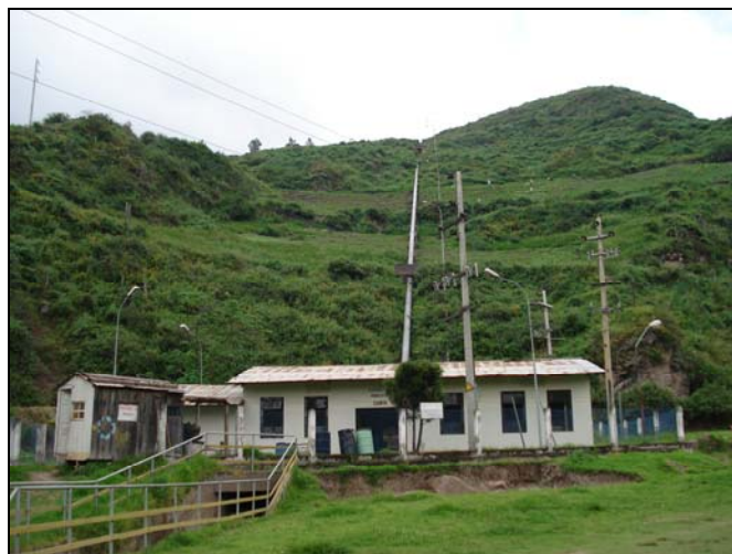
Figura 2.4.- Microcentral Hidroeléctrica de Obrajillo, 1MW
