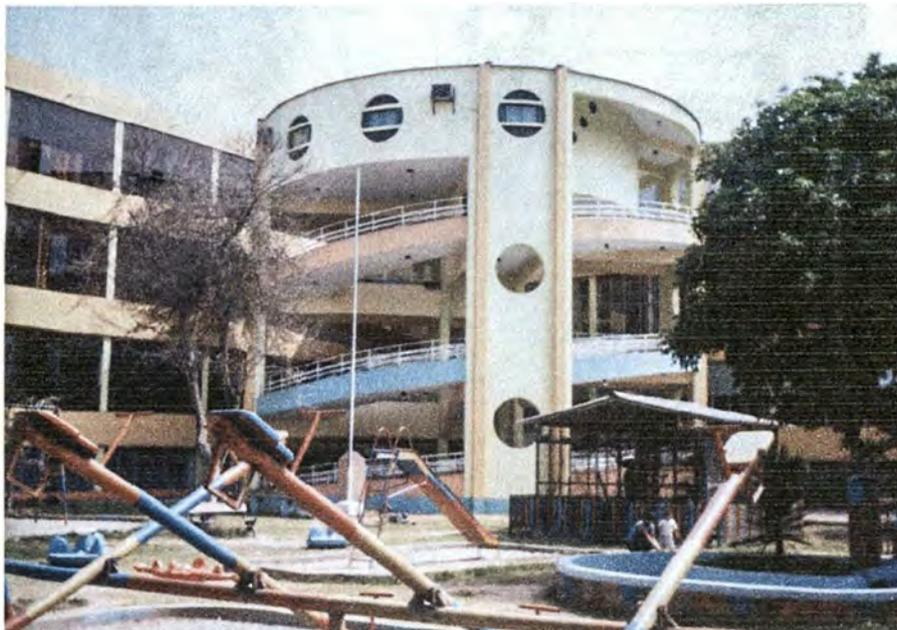
**11.** La Rampa Terapéutica no tiene cerramiento que la proteja del viento y el sol por esta razón no se utilizan los aparatos dispuestos en los descansos. Se plantea el cerramiento con policarbonato traslucido y parasoles.
