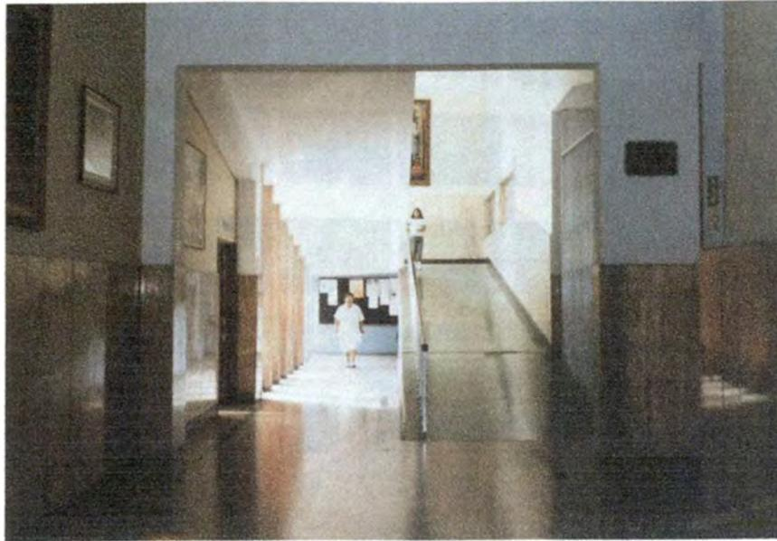
**12.** La Rampa existente en el may Principal tiene pendiente muy alta y su superficie es demasiado resbaladiza. Se plantea remodelar la rampa bajando la pendiente y ampliando el largo de la rampa.
