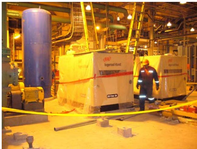
**Figura 4.11:** Montaje Electromecánico de los equipos
