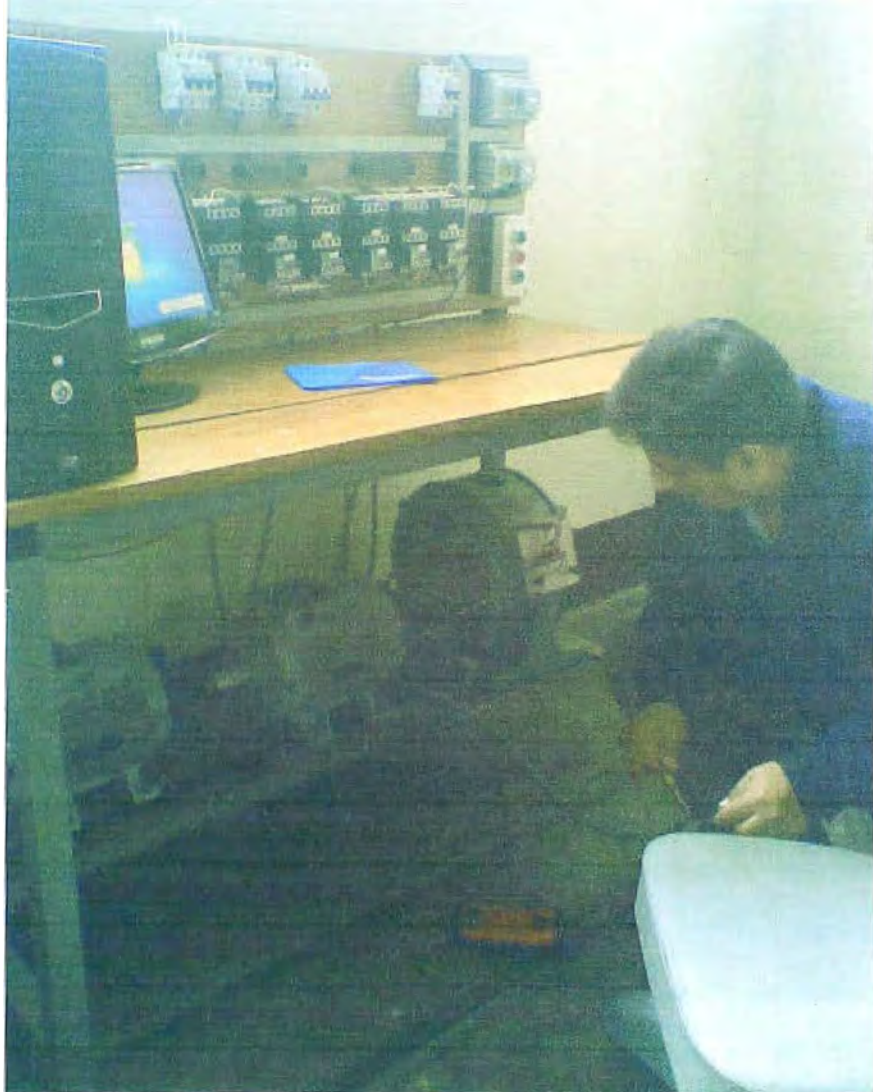
Fotografía C.4 Revisión de las bobinas por fase, conductores y terminales de los motores
