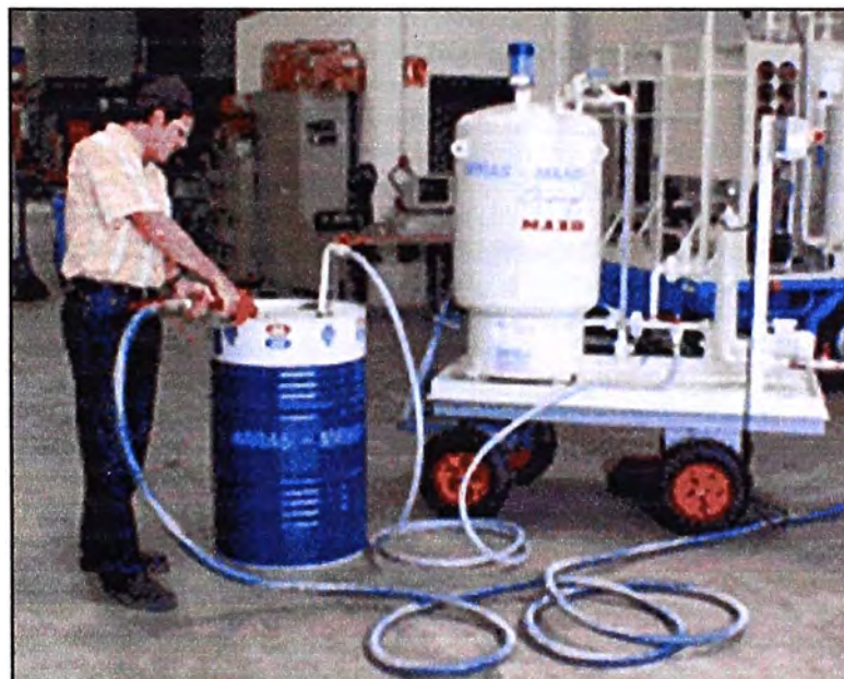
Figura 2.2: Aceite dieléctrico almacenado en tanques para llenar o completar el aceite de otros transformadores
