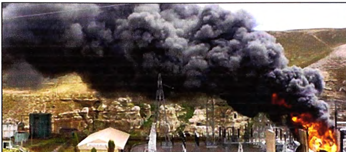
Figura 4.9: Siniestro ocurrido el 24 de Abril de 2011 en S.E. Oroya Nueva
