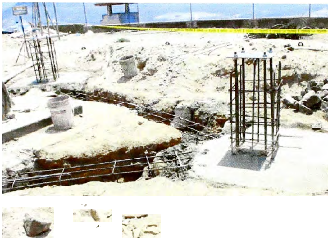
Figura 4.21 llenado de la base de la torre
