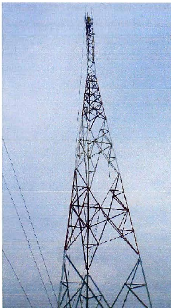
Figura 4.24 Montaje de la parte superior de la torre
