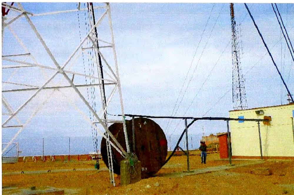
Figura 4.25 Tendido del cable coaxial
