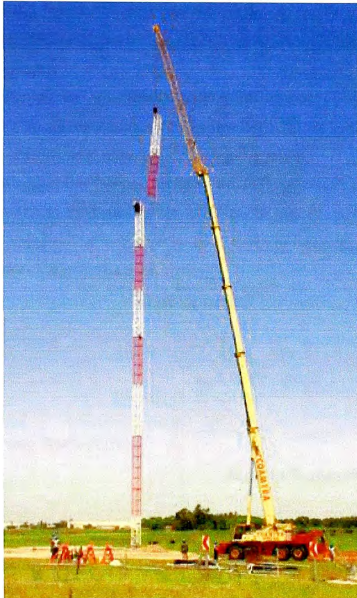
Figura 4.27 Antena arriestrada colocada por una grúa
