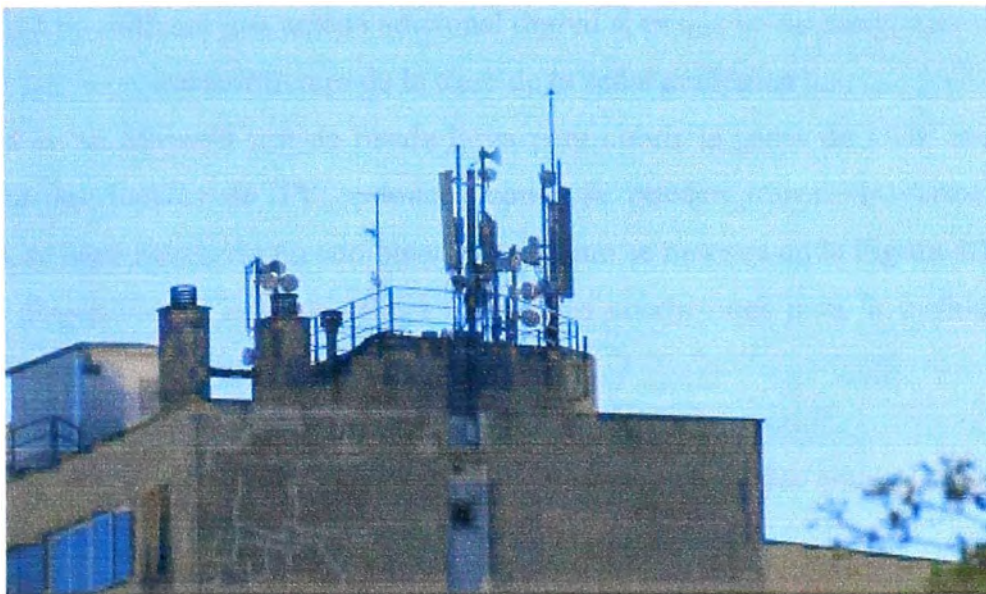
Figura 4.11 Pedestales en la azotea
