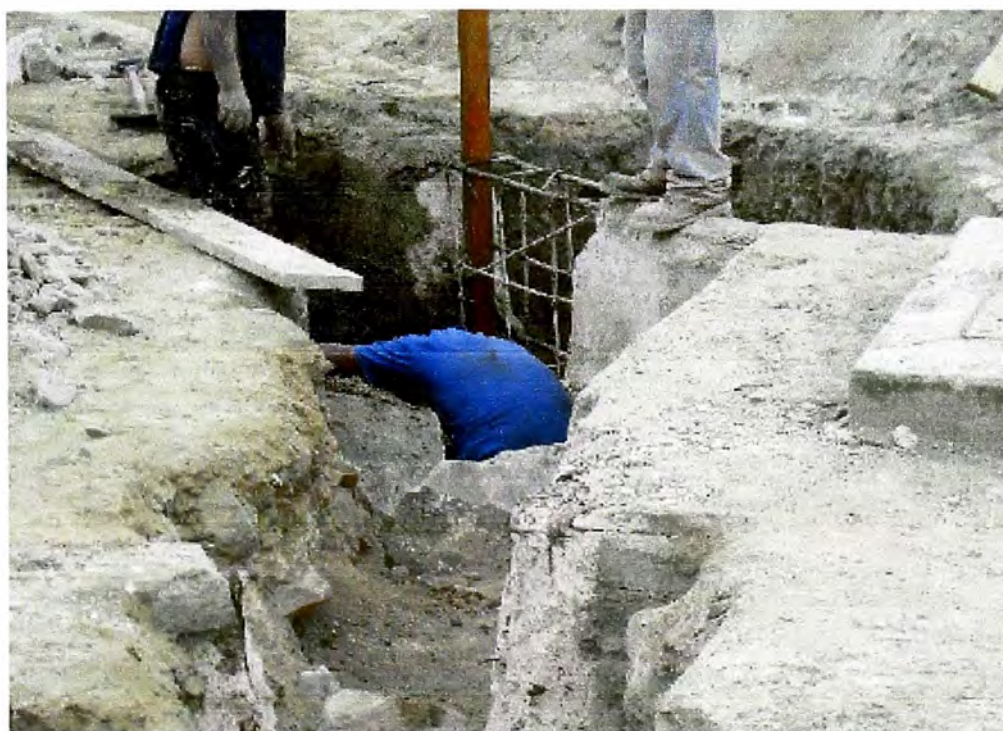
Figura 4.20 Obreros trabajando en la instalación de la torre del IRTP en el morro solar
