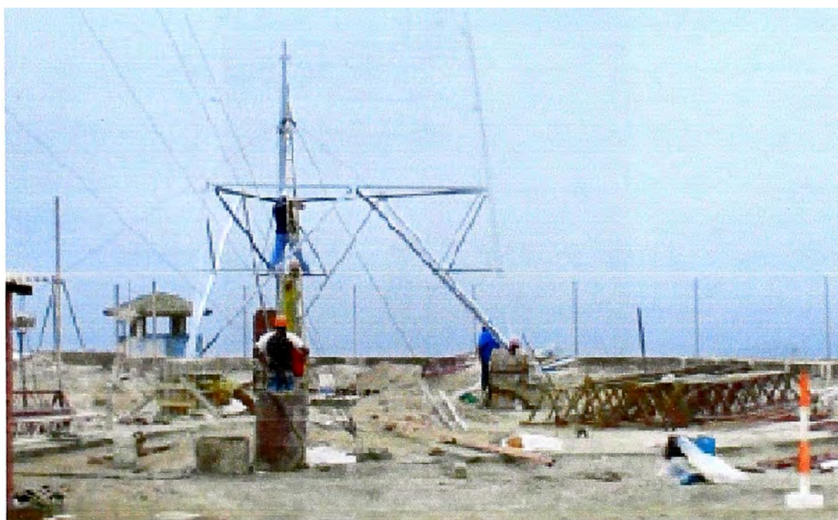
Figura 4.22 Instalación del soporte de la antena
