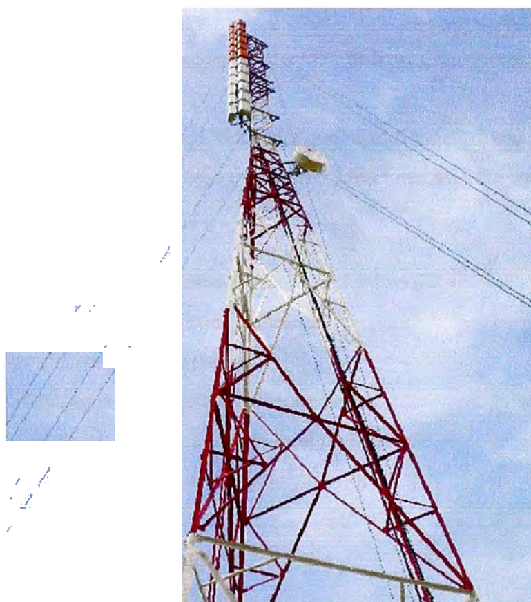
Figura 4.26 Antena del IRTP con la antena de radioenlace y el arreglo de antenas para la transmisión de la señal digital hacia Lima Metropolitana
