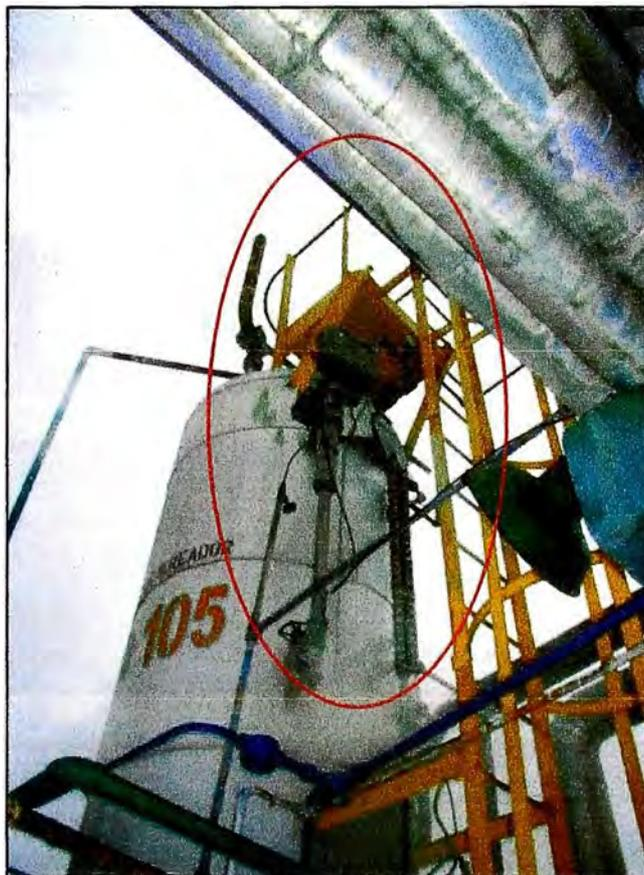
Figura 1.2. Controlador de nivel neumático MASONEILAN.
