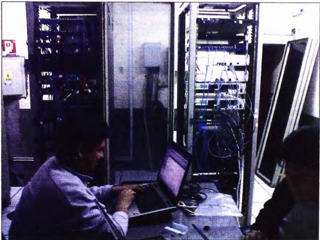
Figura 4.16 Trabajos de configuración y pruebas.
