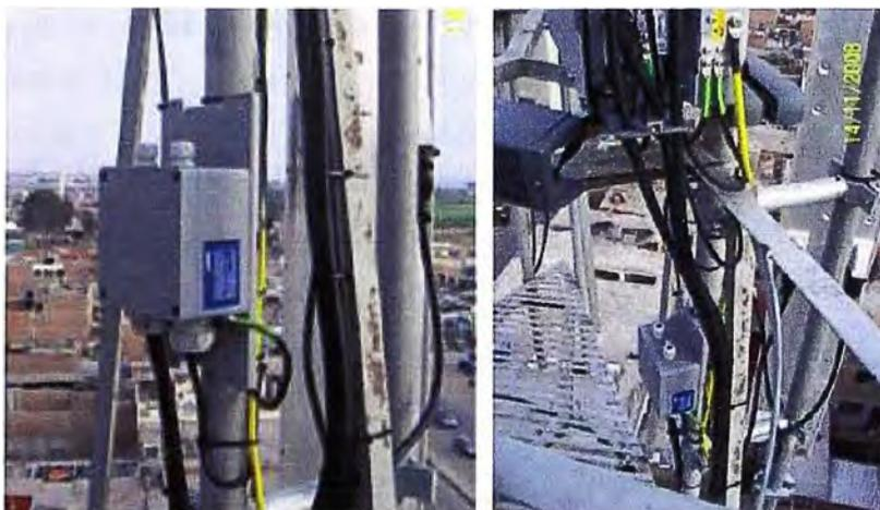
Figura 3.44 Instalación OVP y RF Modulo en torre [1]
