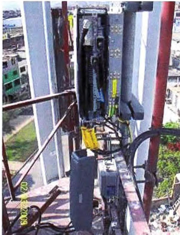
Figura 3.50 Instalación RF modelo y antena UMTS [1]
