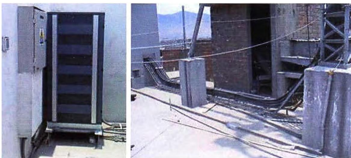
Figura 3.45 Instalación de F.O. y cable de energía DC [1]
