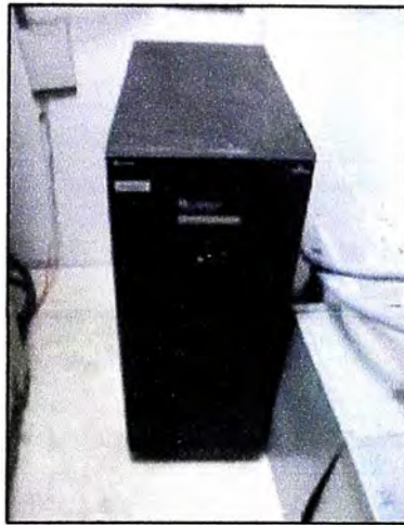
Figura N°3.4: Ups Alimentación de equipos de Cómputo y Comunicaciones
