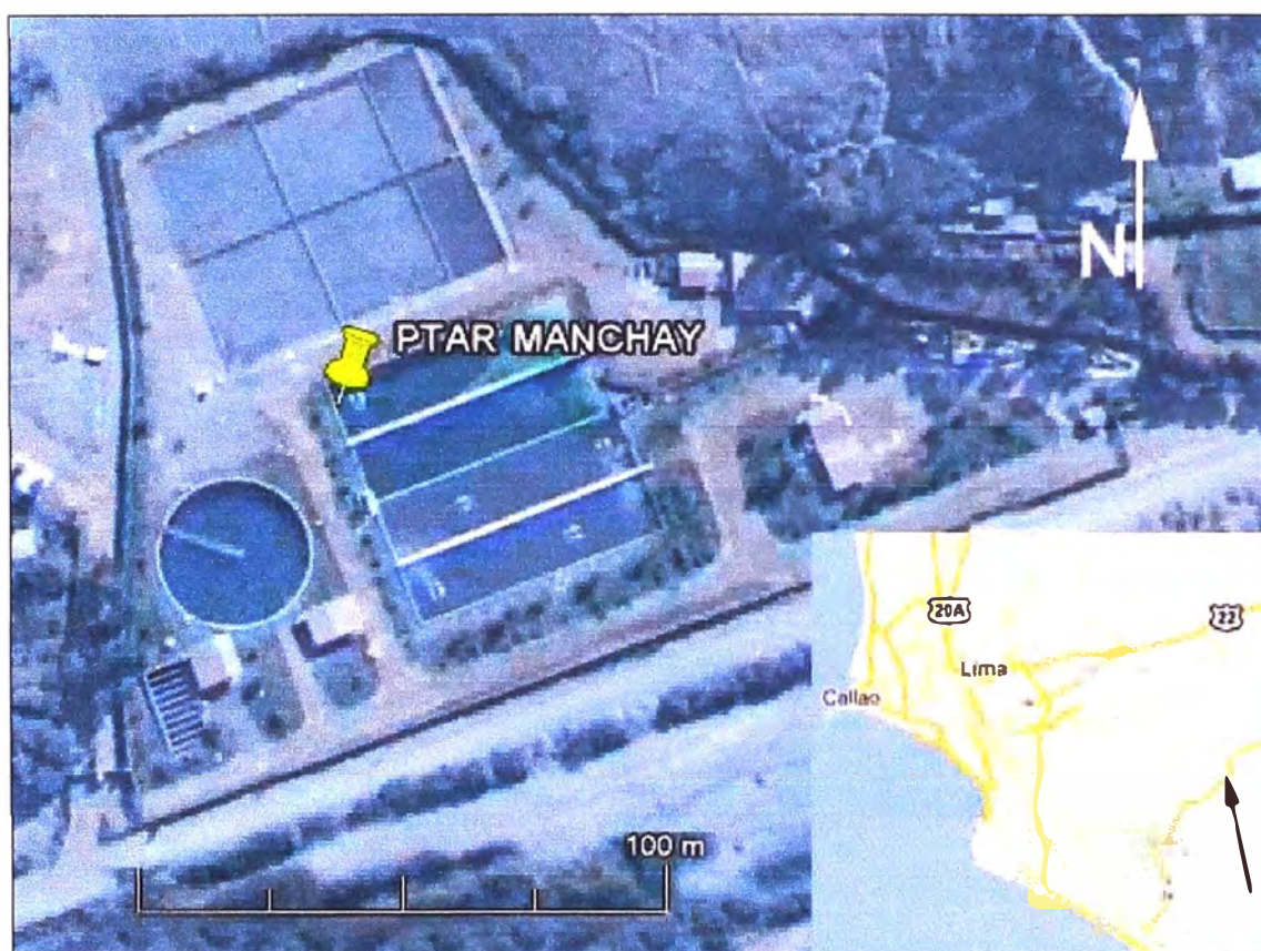
Figura 1.1 Vista aérea de a Planta de Tratamiento de Aguas Residuales Manchay
