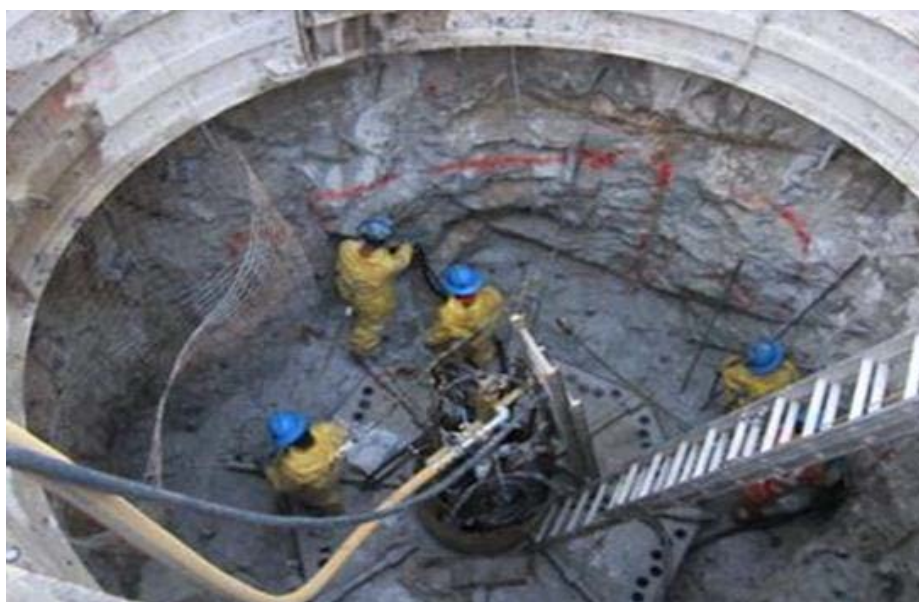
Figura 3.5 Sostenimiento del pique
