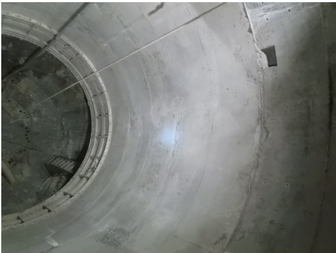
Figura 3.5 Revestimiento del pique
