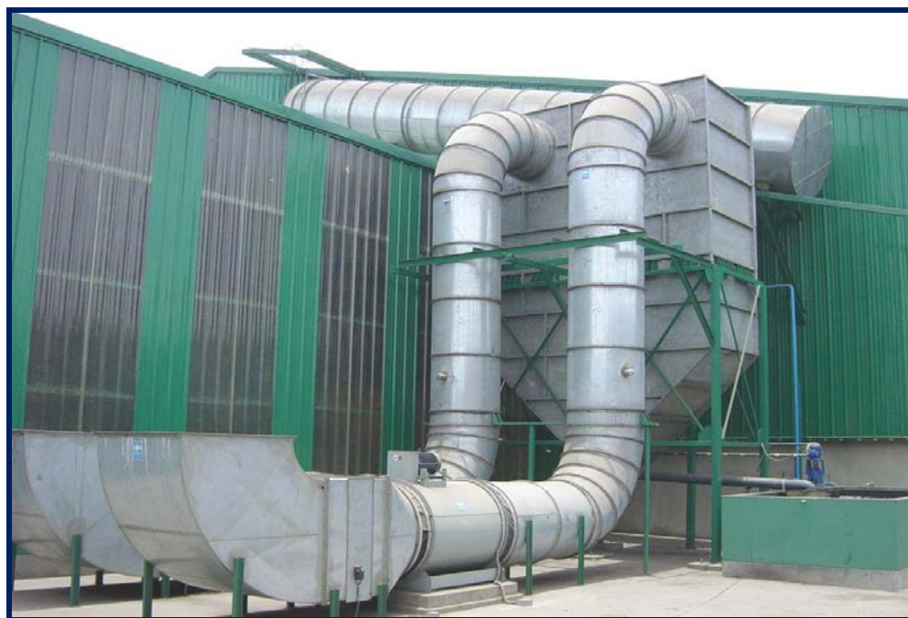
Figura 18. Sistema de extracción de partículas y limpieza de aire en presión negativa
