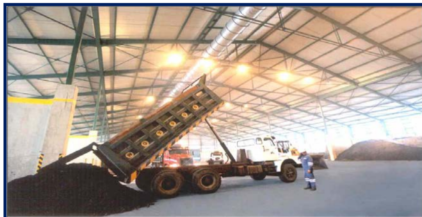
Figura 17. Interior del Almacén hermético de concentrados de plomo
