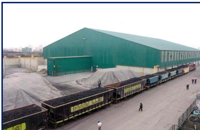
Figura 16. Almacén hermético de concentrados de plomo con sistema de ventilación en presión negativa
