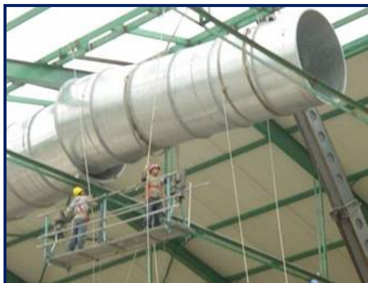
Figura 15. Etapa de construcción del depósito hermético
