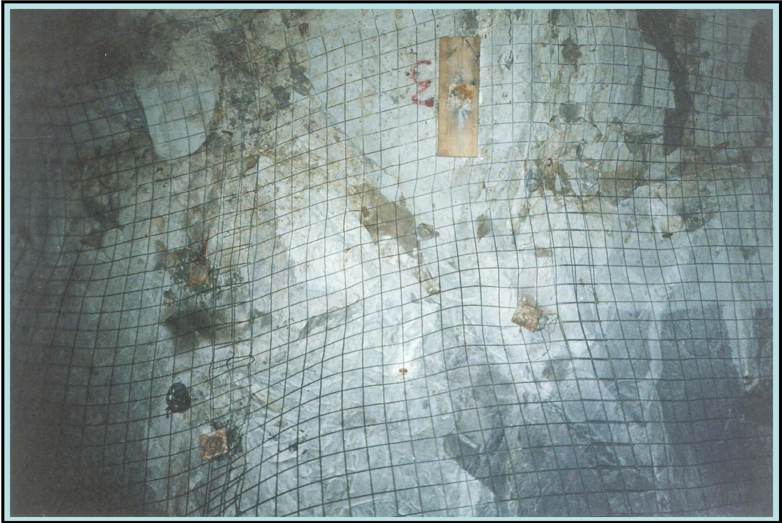
Sostenimiento con Perno y malla electrosoldada en un macizo rocoso MF/P
