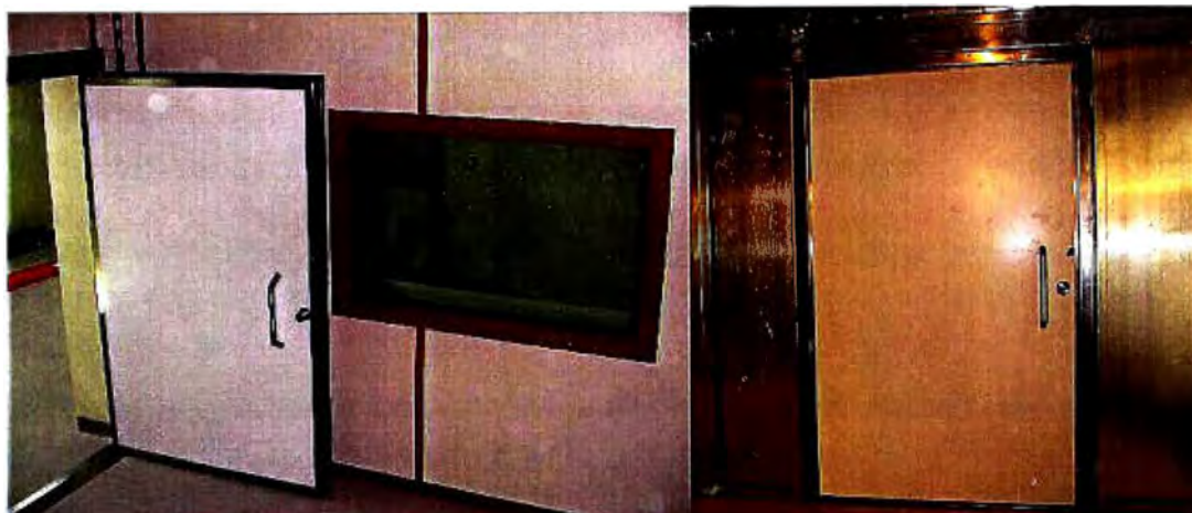
Figura 2.8 Puerta y ventana con terminaciones (izquierda) / Puerta en blindaje de Aluminio sin terminaciones (derecha)
