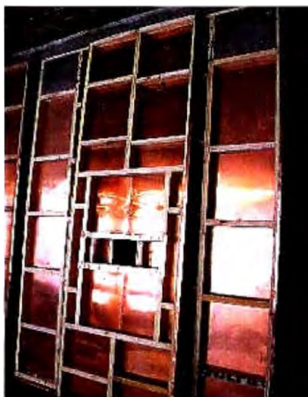
Figura 2.4 Pared de blindaje RF con material de cobre
