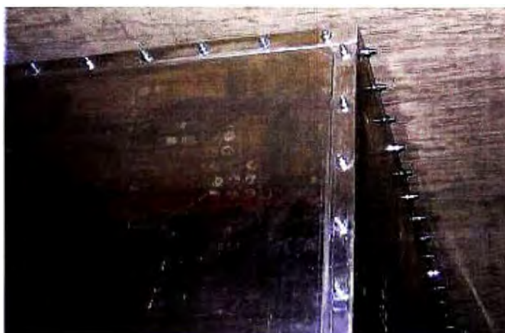
Figura 3.5 Detalle de blindaje RF con material de aluminio
