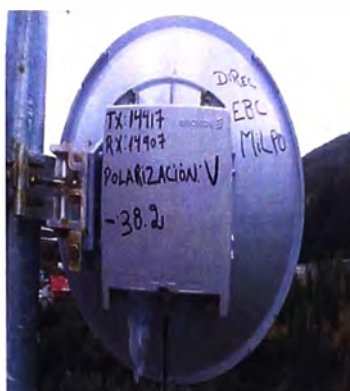
Figura 3.33 Antena en El Porvenir con dirección a EBC Milpo (Fuente: Elab. propia)
