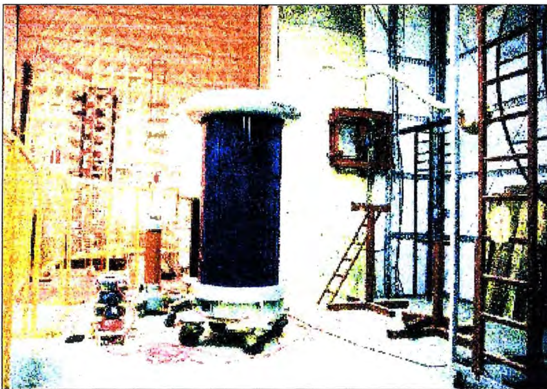
Fig. ANEXO A.7: Sala de ensayos de efecto corona. Vista del transformador de pruebas , bobina serie y capacitor patrón.
