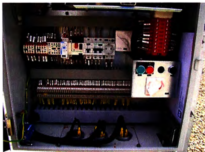
Figura 4.1. Caja de Mando del Seccionador SB-3857
