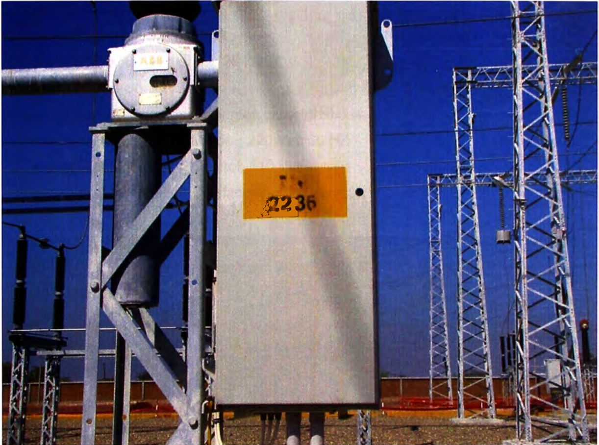
Figura 1.2. Interruptor de Potencia IN-2236
