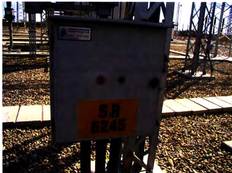
Figura 4.2. Caja de Mando del Seccionador SB-6245
