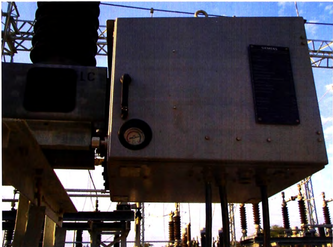
Figura 1.3. Interruptor de Potencia IN-6114
