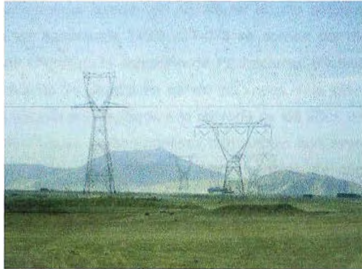
Figura 4.8 Torres ubicadas entre los V-08 y V-10
