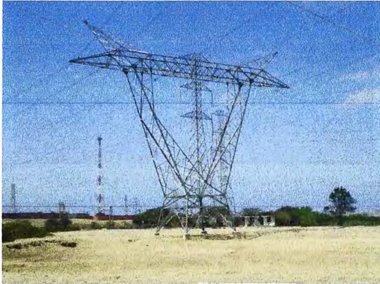
Figura 4.1 Torre ubicada entre S.E. Chilca y V-03
