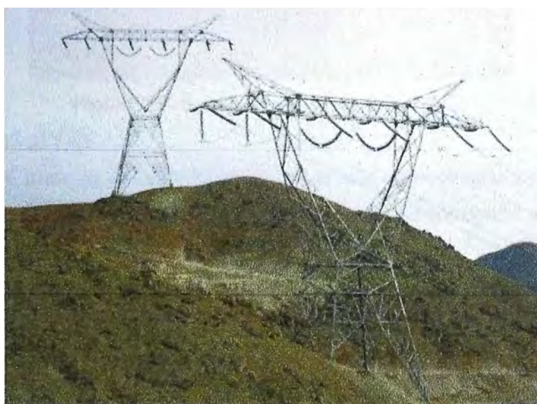
Figura 4.6 Torre ubicadas entre los V-28 y V-32
