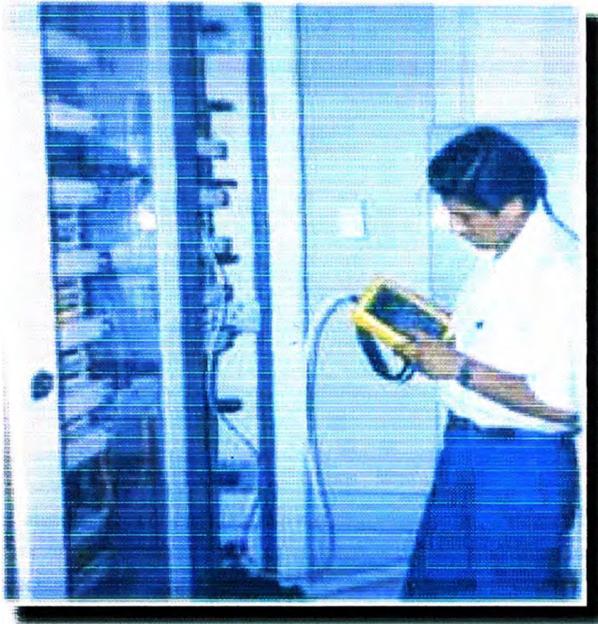
Fotografía 5.5.3 Mediciones y pruebas en el MDF.
