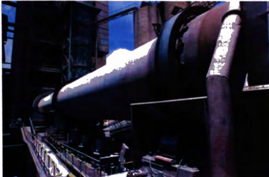
Fig 2.3 Horno Rotativo de Clinker (longitud 50 mts y diámetro 3.6mts)
