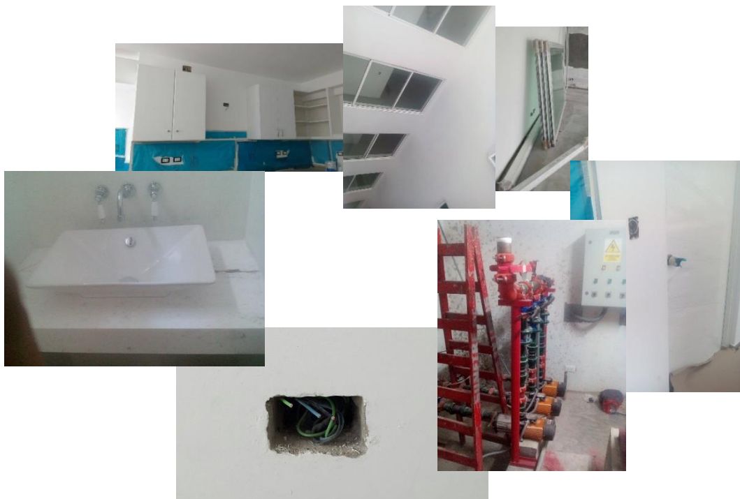
Figura N°5.3: Imágenes de algunas especialidades de acabados en obra Fuente: Elaboración propia.
