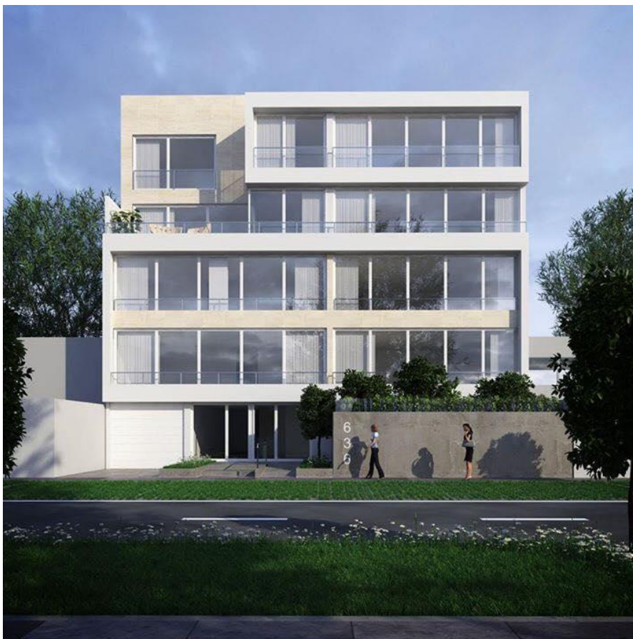
Figura N°5.2: Fachada del edificio Castel Nuovo. Fuente: Empresa Innovare.
