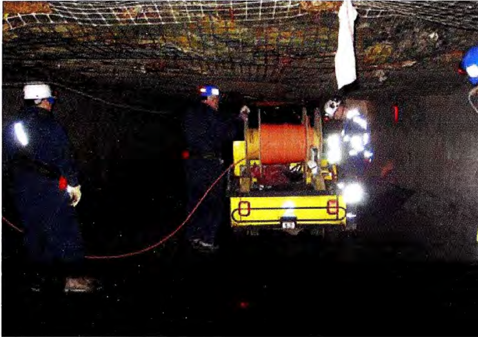
Fig. 2.7 Tendido de la fibra Óptica en el interior de la mina.
