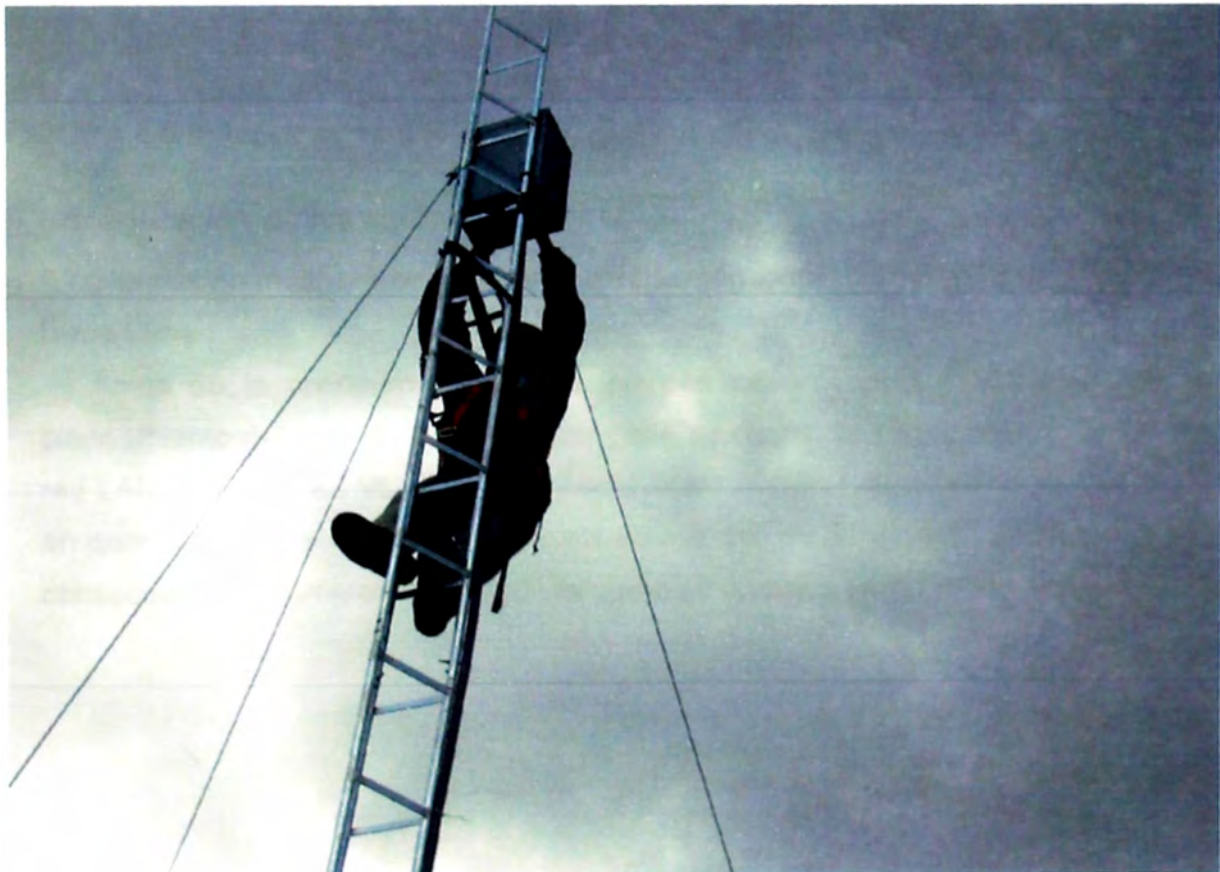
FIGURA 4.2 Instalación de equipos inalámbricos
