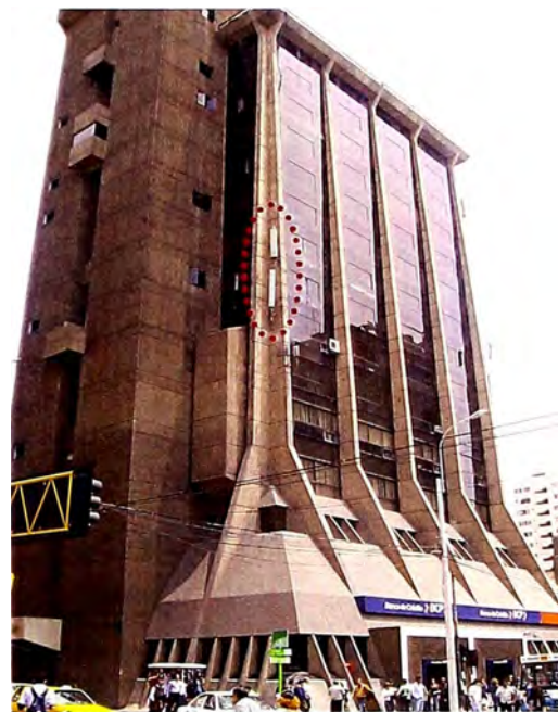
Fig.2.7 EBC Shell con antenas instaladas en la parte lateral del edificio. Fuente: Elaboración Propia
