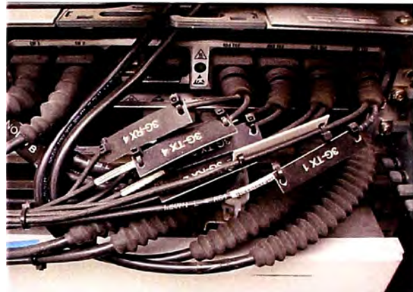
Fig. 3.26 Instalación de 4 E1s coaxiales flex 2 en el módulo de transmisión Fuente: Elaboración Propia
