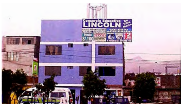
Fig.2.4 EBC Diego Ferrer con antenas instaladas a una altura menor a la deseada.
