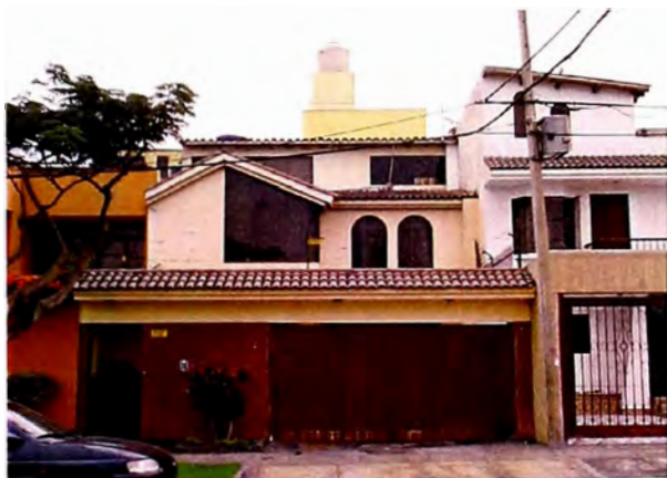
Fig. 3.43 Casa con tanque mimetizado. Fuente: Elaboración Propia
