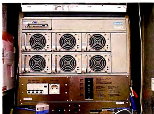
Fig. 3.18 Rectificador GSM BS241 Fuente: Elaboración Propia
