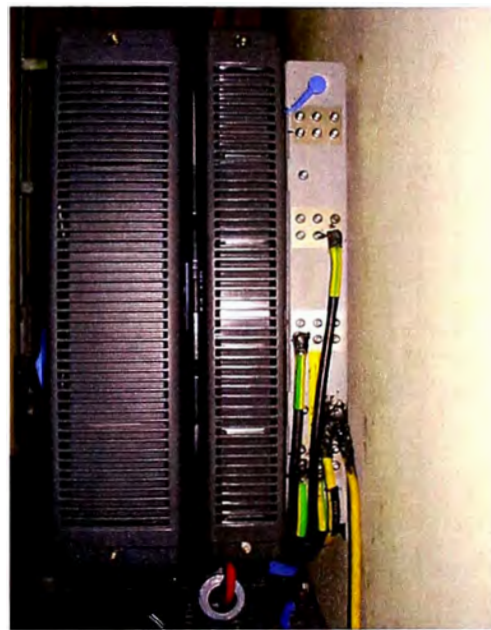
Fig. 3.21. Modulo 3G FPMA (AC/DC) en solución a pared Fuente: Elaboración Propia
