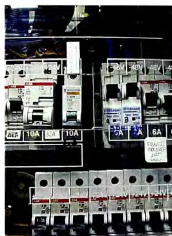
Fig. 3.17 Rectificador con Breaker para UMTS Fuente: Elaboración Propia
