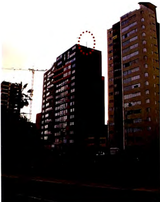
Fig.2.6 EBC Lavalle con antenas instaladas en la azotea. Fuente: Elaboración Propia
