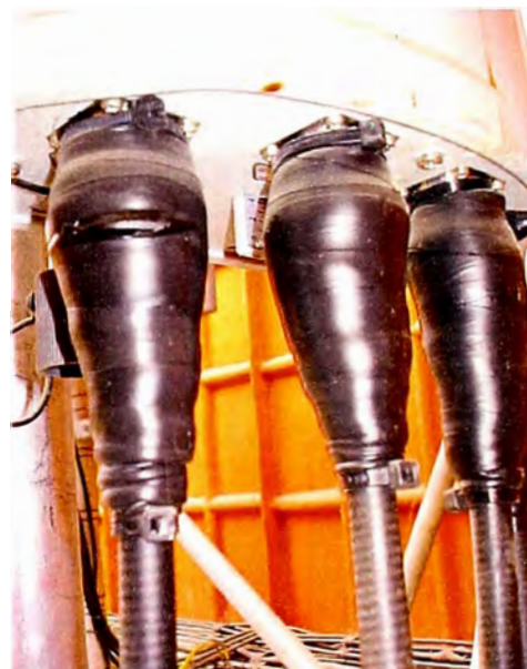
Fig. 3.34 Jumpers conectado a la antena están vulcanizados Fuente: Elaboración Propia
