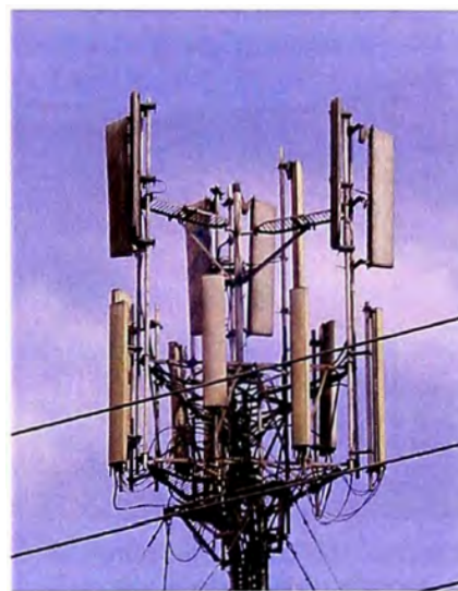
Fig. 3.40 Ampliación de torres con mástiles. Fuente: Elaboración Propia
