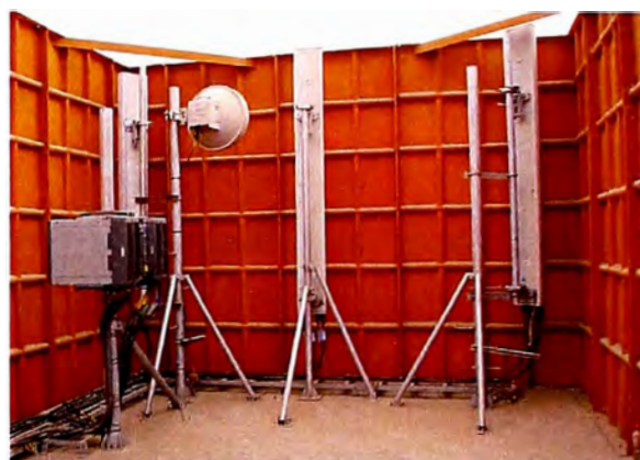
Fig. 3.42 Antenas dentro del mimetizado. Fuente: Elaboración Propia
