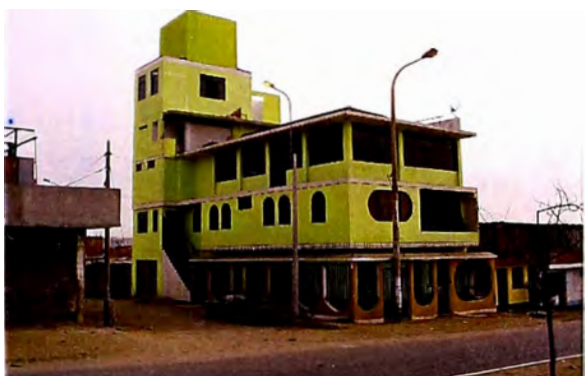
Fig. 3.41 Casa con mimetizado en azotea. Fuente: Elaboración Propia
