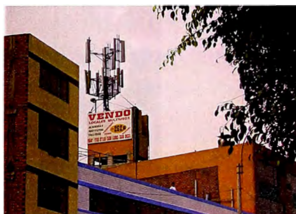
Fig.2.5 EBC Manzanos con antenas instaladas a una altura menor a la deseada.
