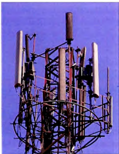
Fig. 3.39 Ampliación de torres con mástiles. Fuente: Elaboración Propia
