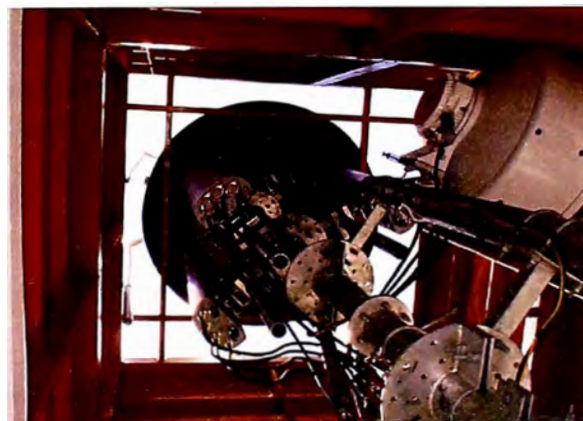
Fig. 3.44 Antenas dentro de tanque de agua. Fuente: Elaboración Propia
