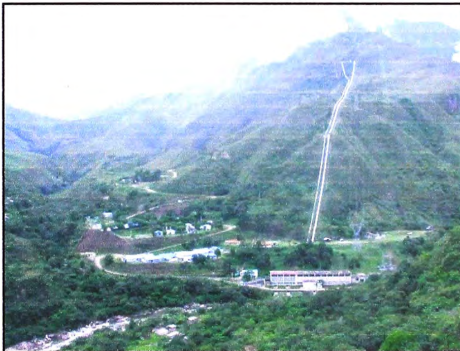
Fig. 4.1 Vista panorámica de la CH Yaupi
