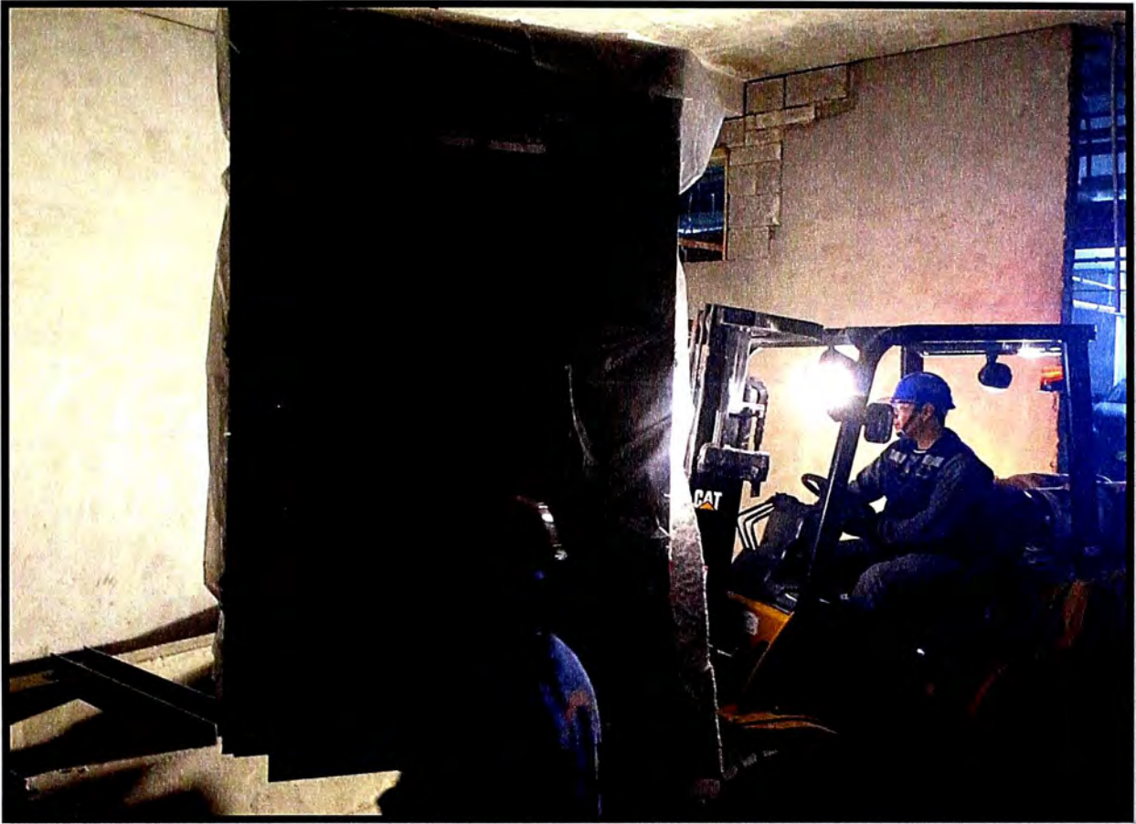
Fig. 3.14 (Foto 1 – Movilización de Transformador de 1250 KVA)
