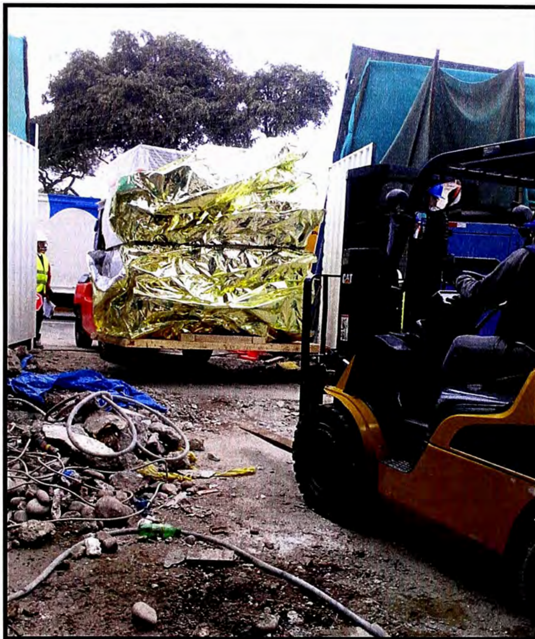
Fig. 3.5 (Foto de transformadores llegando a obra)
