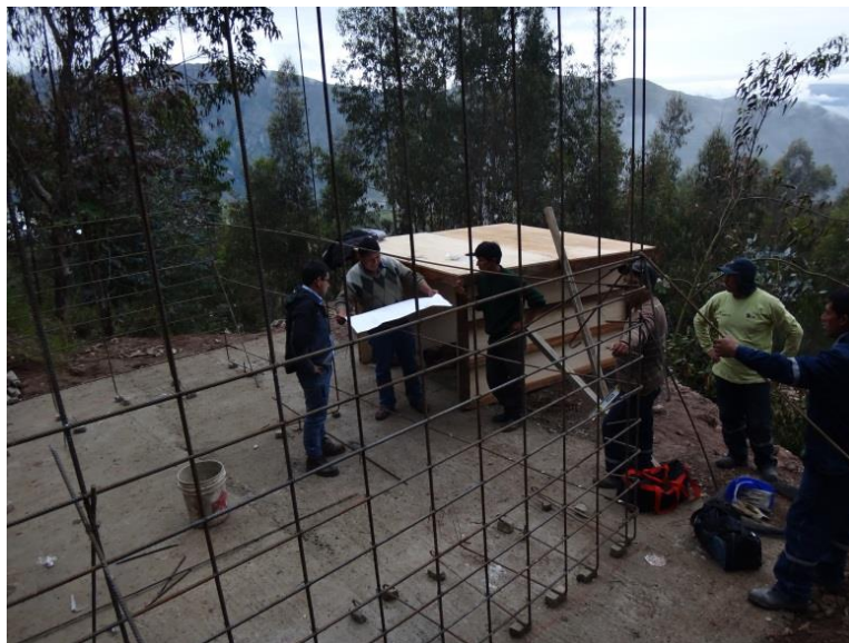
Figura N° 20: Colocación de acero, se colocó dados de concreto para dar el espaciamiento para el recubrimiento especificado en los planos.
