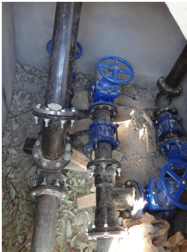
Figura N° 22: En la parte derecha se observa la tubería que ingreso de agua al reservorio, la parte central es la tubería de salida hacia las redes de agua y la izquierda es la tubería de rebose que se une a la de limpia.
