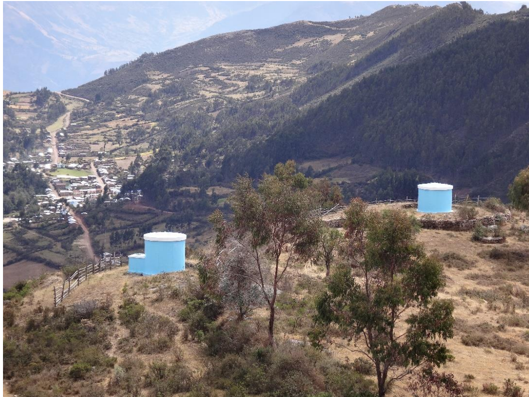
Figura N° 7: Reservorios existentes antiguos de 12 m 3 de capacidad cada uno.
