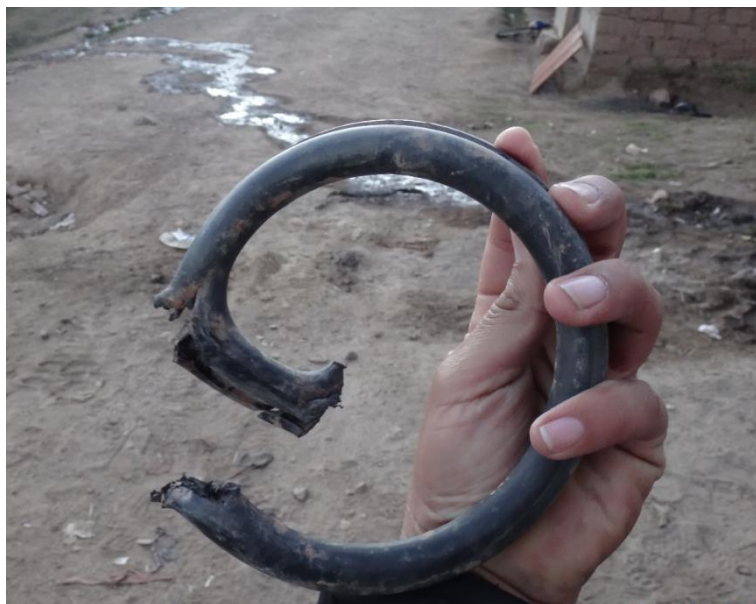
Figura N° 19: Se observa el anillo de caucho “mordido” por las tuberías de Hierro Dúctil debido a un deslizamiento de tierra.
