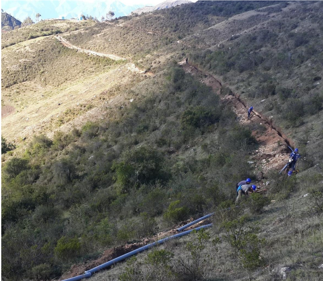
Figura N° 14: Suministro de tubería de PVC en la línea de aducción.
