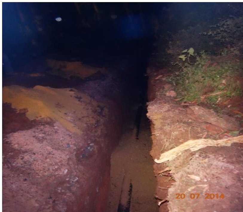
Figura N° 15: Colocación de material de préstamo, una capa de 30cm sobre la clave del tubo, compactado cada 15cm de espesor.
