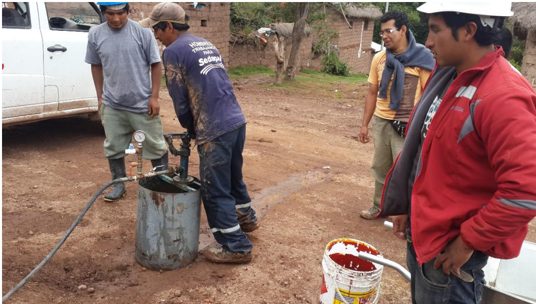
Figura N° 26: Se observa el levantamiento de presión en las redes de agua, con un balde de prueba acondicionado con un manómetro calibrado.
