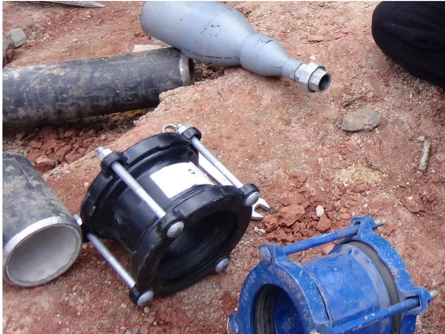
Figura N° 16: Unión de brida para empalmar tubería de PVC con Hierro Dúctil.
