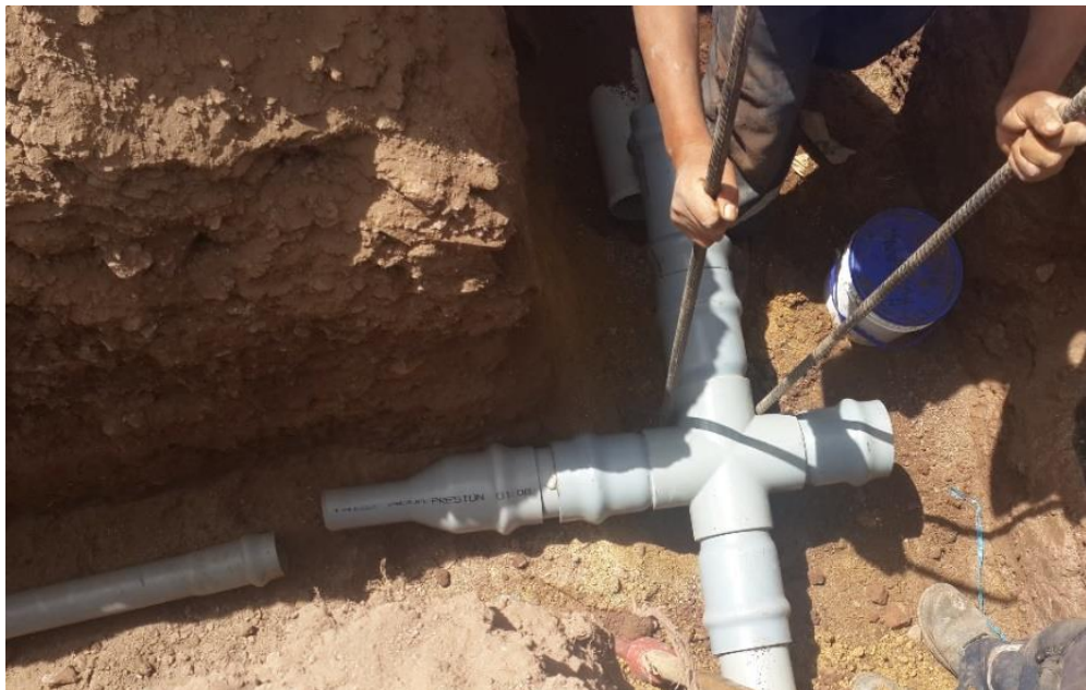
Figura N° 24: Se observa la presentación de como quedara instalado el accesorio, en este caso una cruz.
