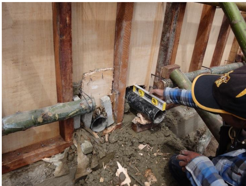
Figura N° 21: Colocación y nivelación de bridas rompe agua para salida y limpia del reservorio.
