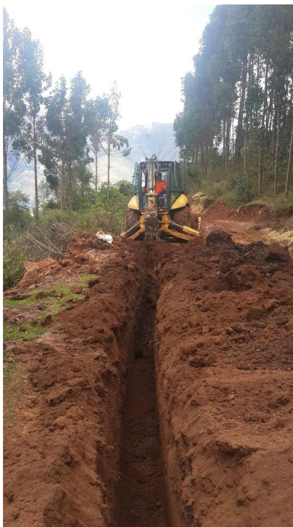
Figura N° 11: Excavación en tramos de carretera, accesible para utilizar una retroexcavadora.
