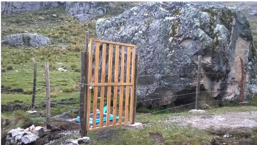
Figura N° 10: Vista de la captación.
