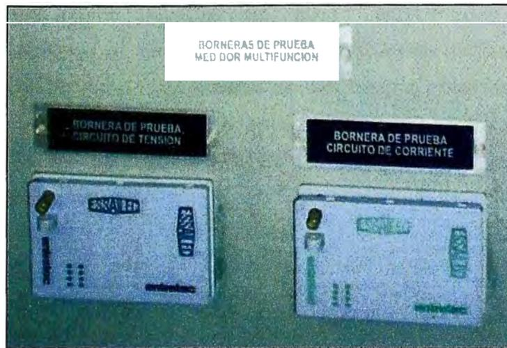
Figura 4.5 Borneras Tipo Entrelec de Tensión y Corriente
