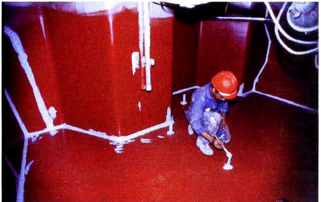
Figura 12: Personal realizando refuerzos a los cordones de soldadura y cantos vivos en interior de tanque.
