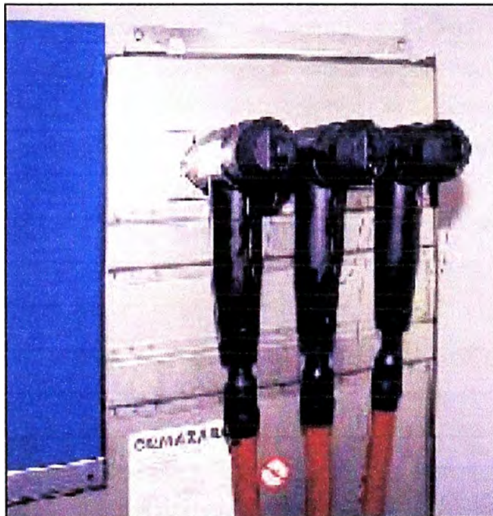
CONEXIÓN DIRECTA AL EMBARRADO
