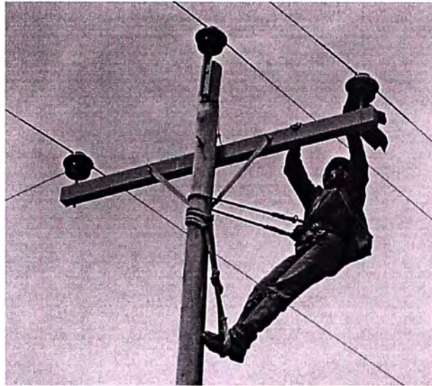
Fig. 3.3 Mantenimiento Preventivo- Limpieza de Aisladores
