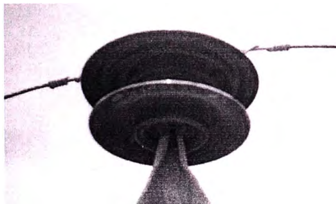
Fig. 2.7. Pérdidas de la Capacidad de Aislamiento por la Contaminación
