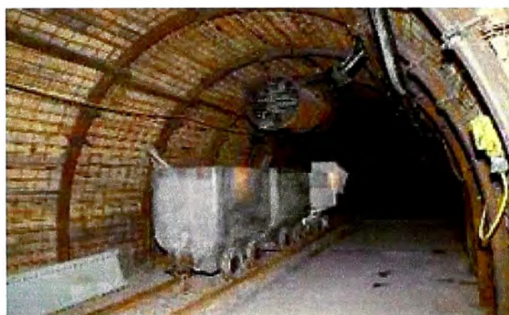
Figura 4.4 Pruebas a controlar arrancado y apagado de un ventilador de 250 HP [3]
