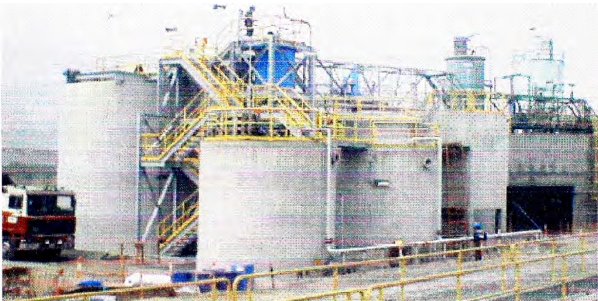
Fig. 2 Montaje de la planta de Recuperación de Zinc
