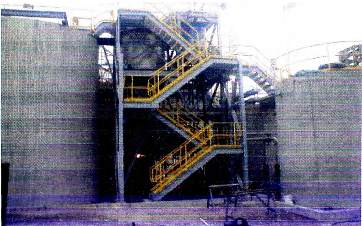
Fig. 1 Montaje de escalera entre tanques de alimentación y de proceso
