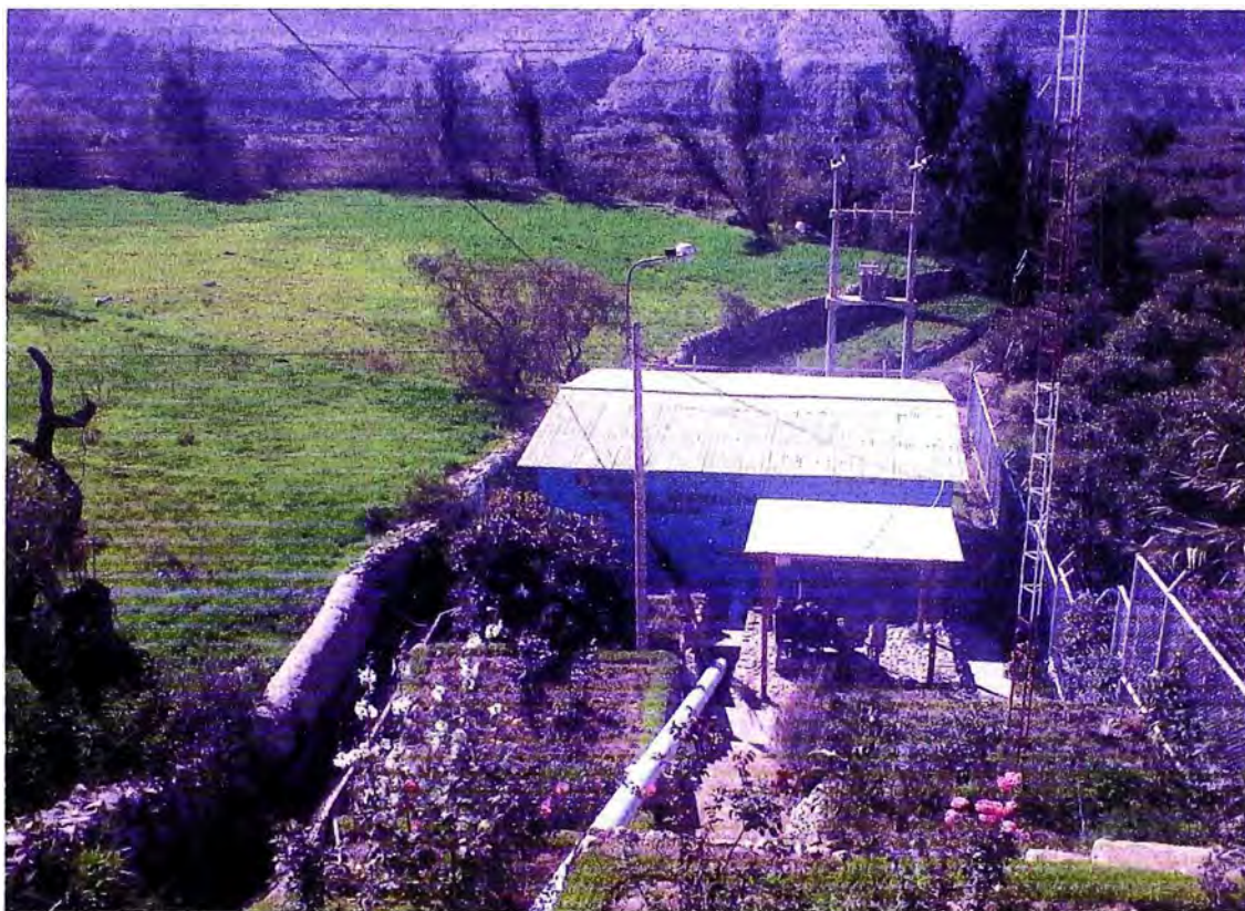
Foto 05: Mini Central del SER Quicacha, que posee alimentación hidroeléctrica y térmica.
