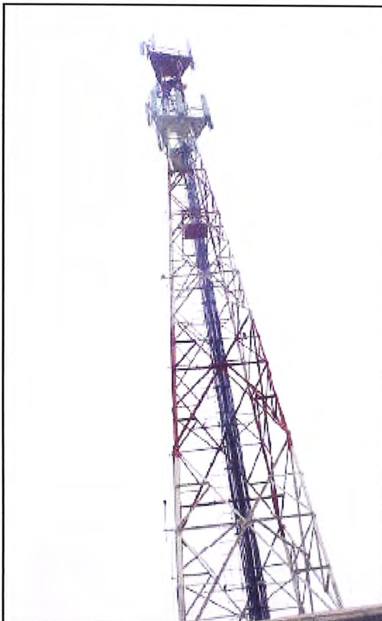
Figura 1.2 Torre en Zona Urbana (Fuente: Empresa Telefónica Móviles)
