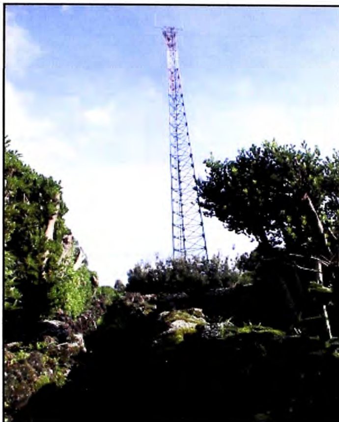
Figura 1.1 Torre en Zona Rural (Fuente: Empresa Telefónica Móviles)
