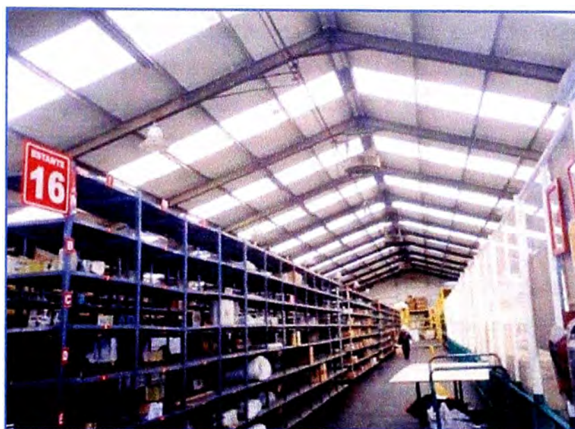
Fig. N° 4.12 Techos translúcidos en almacenes
