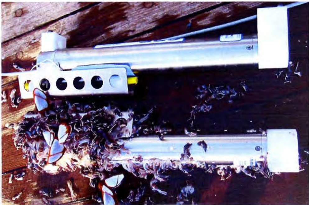
Fig. 6.4: CT de 7m retirado para ser reemplazado por otro
