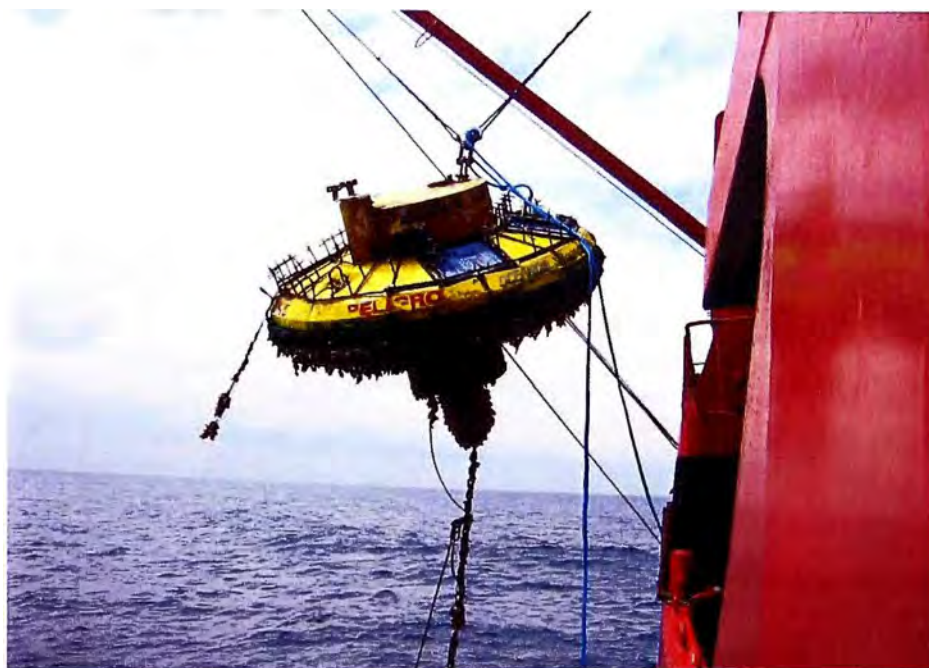
Fig. 5.15: Izado de la boya a ser cambiada
