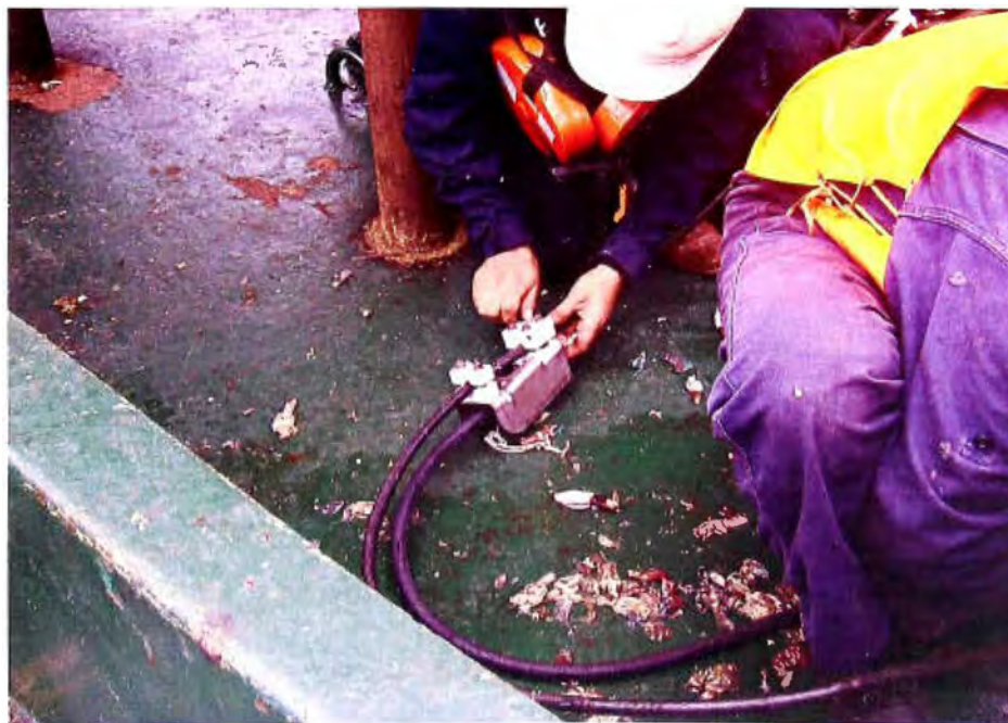
Fig. 5.18: Colocación del nuevo cable acoplador inductivo de la boya de recambio
