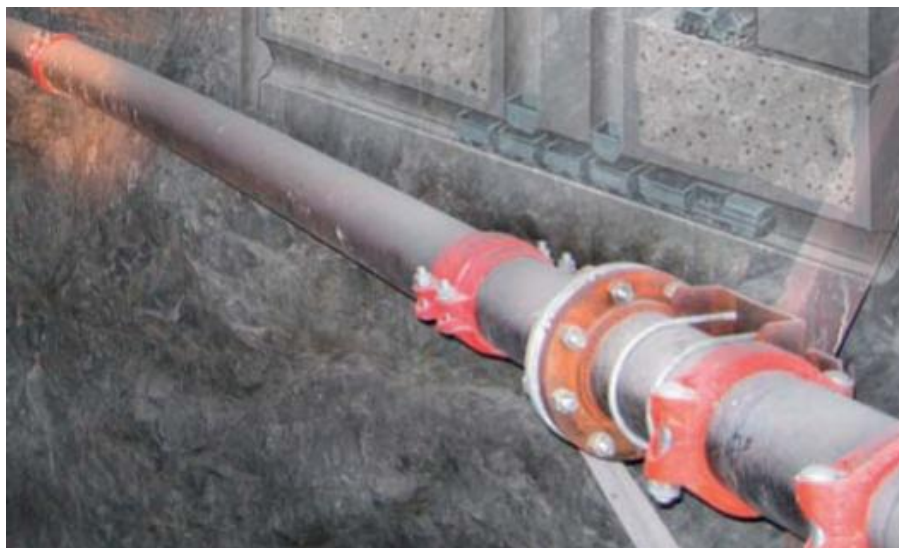
Figura 7.1 Empalmes instalados en las tuberías
