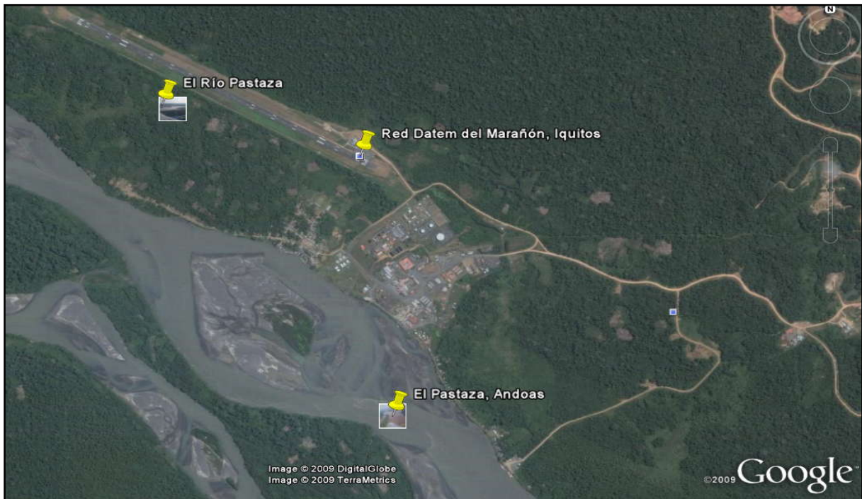
FIG 8.3 VISTA PANORÁMICA DE LA ESTACIÓN ANDOAS
