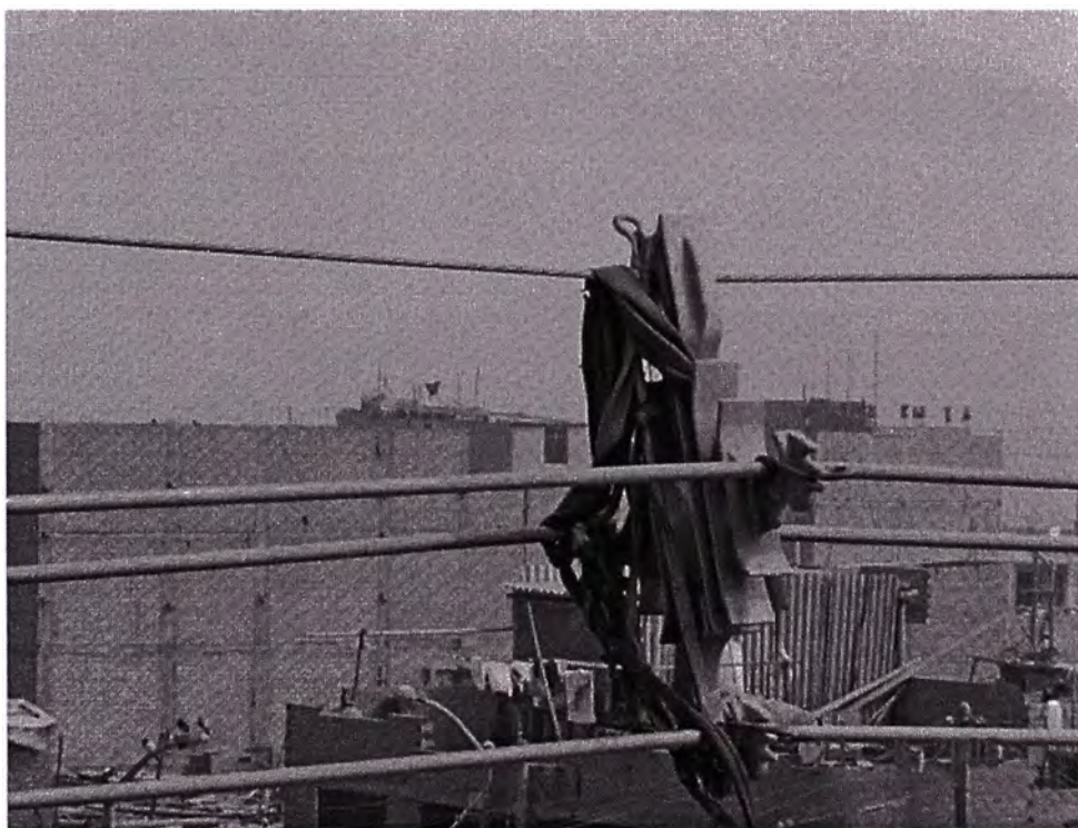
Foto 4.- Espaciador a mitad de vano con objeto entre fases.
