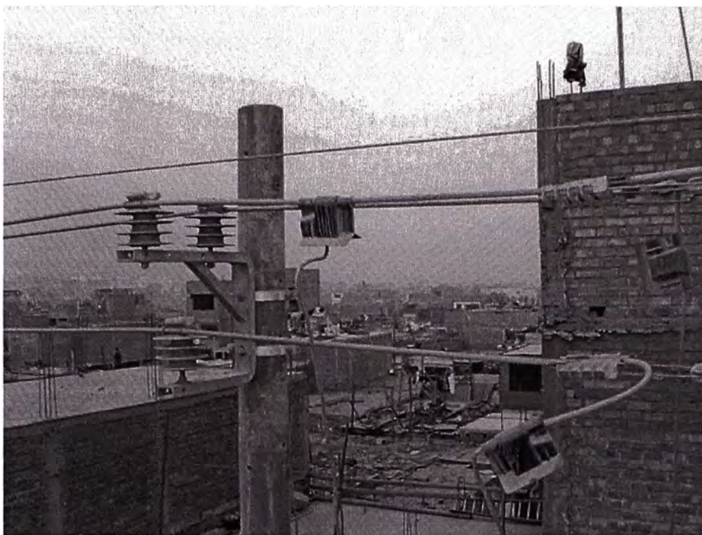
Foto 3.- Armado de ángulo.
