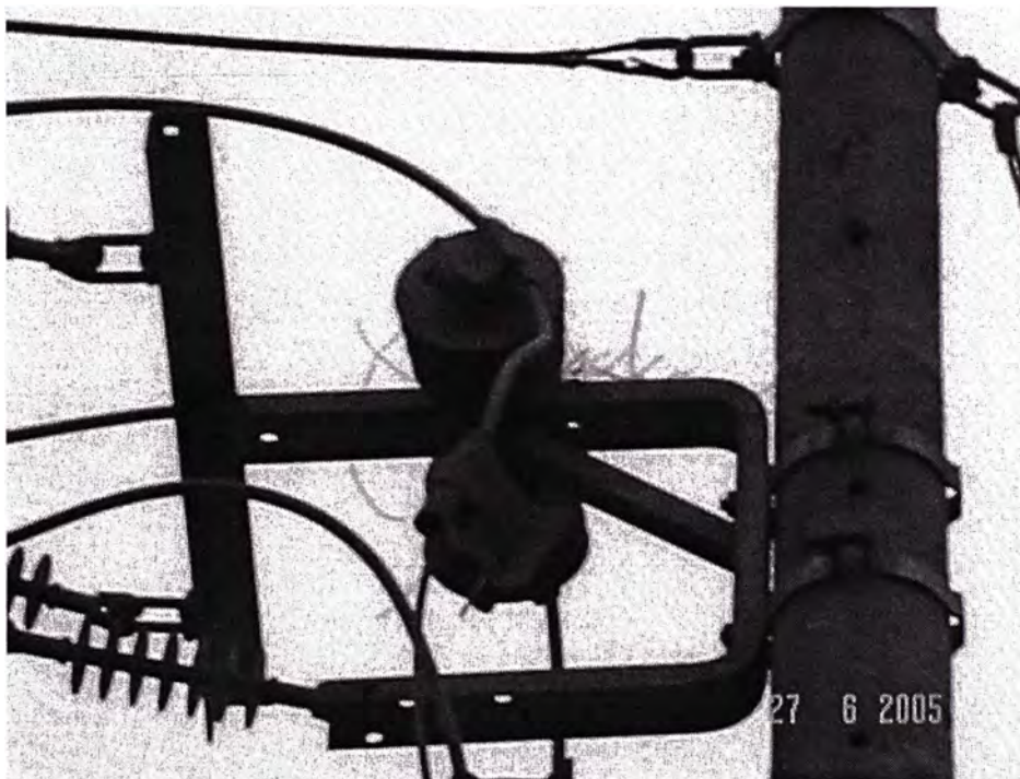
Foto 12.- Armado CE-3 para fin de línea.
