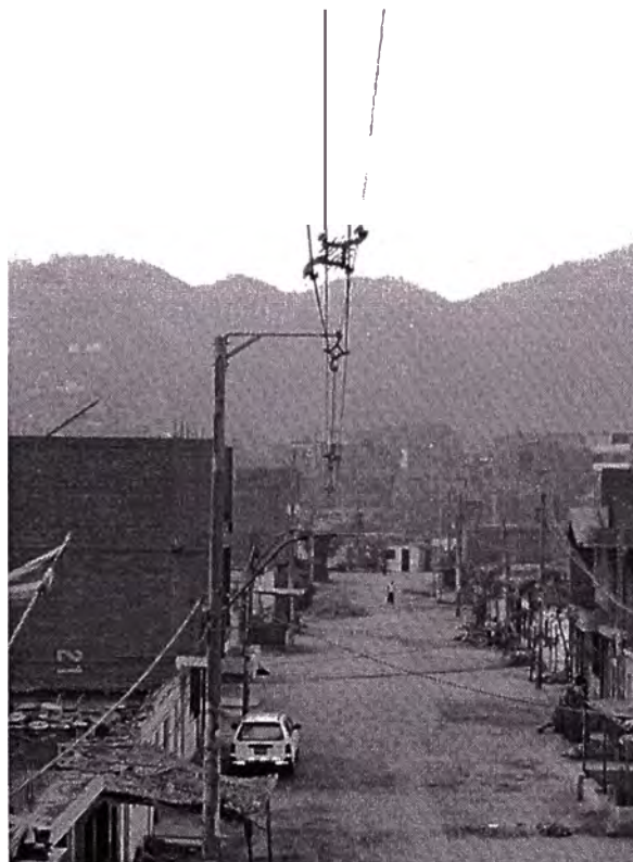
Foto 2.- Armado de alineamiento CE-J2.
