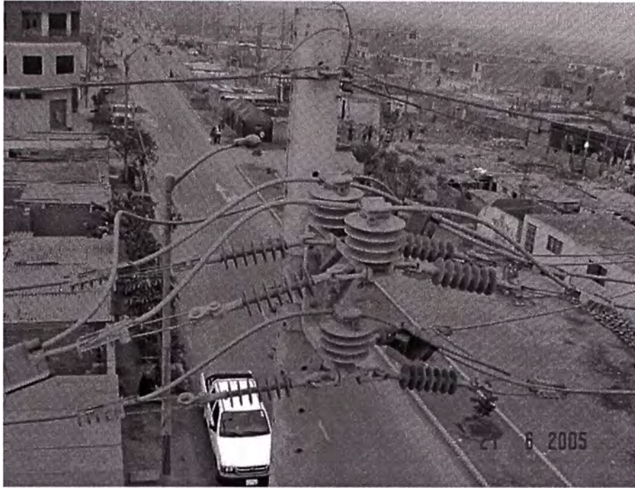
Foto 5.- Armado en ángulo de deflexión.
