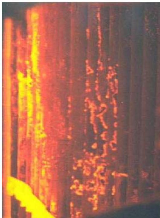
Figura N° 4.2: Ensuciamiento de Zona Radiante
