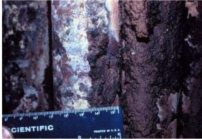
Figura N° 4.10: Corrosión por cenizas fundidas
