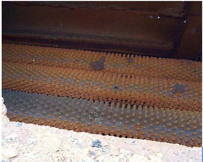
Figura 2.16: Tubos entetonados –Stud tubes en uso
