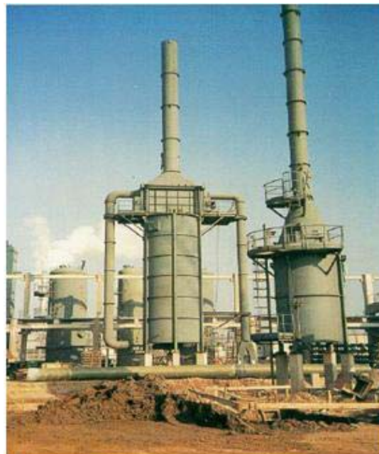
Figura 2.2: Hornos Cilíndricos Verticales con Zona Radiante y Convectiva (lado izquierdo), y sólo Zona Radiante (lado derecho)
