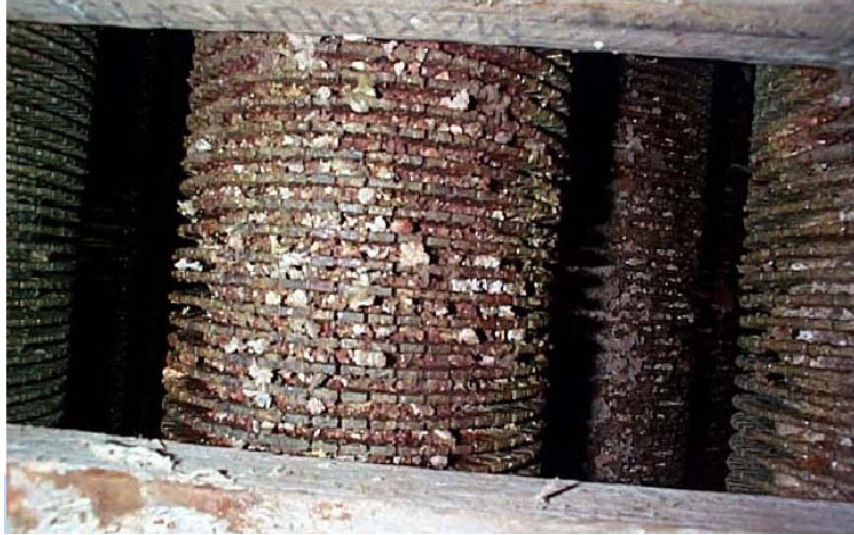
Figura 2.14: Tubos aletados segmentados después de limpieza
