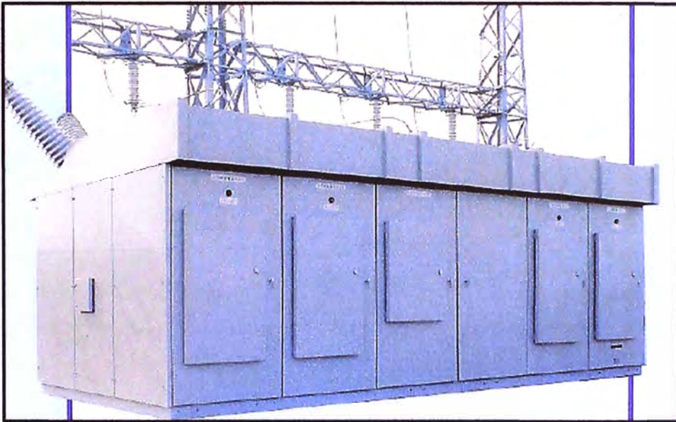
Figura 1.6 Celdas C-GIS montadas en un patio, en 72,5kV
