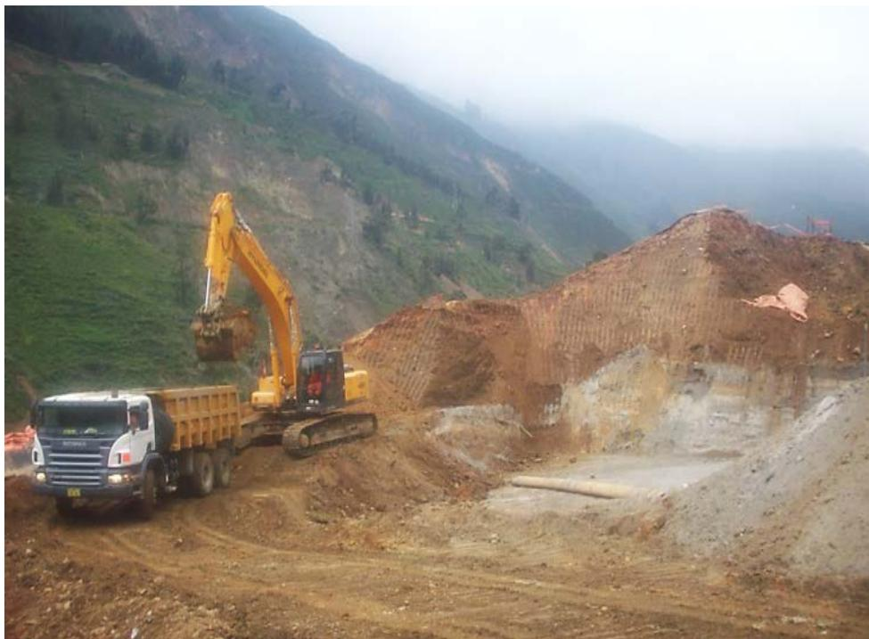
**Figura 9.1 Excavadora cargando camión**
