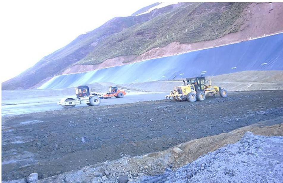
**Figura 5.2 Equipos nivelando y compactando el relave**
