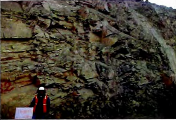
Fotografía de detalle del Macizo Rocoso.
