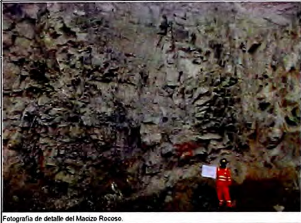
Fotografía de detalle del Macizo Rocoso.
