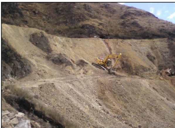
Figura 5.4 Perfilado de desmonteras
