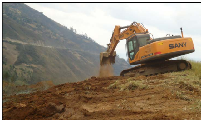
Figura 5.9 Perfilado de desmonteras
