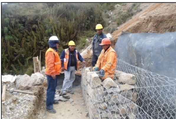
Figura 5.5 Construcción de gaviones en desmonteras
