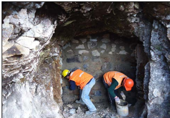
Figura 5.3 Tapado de bocaminas
