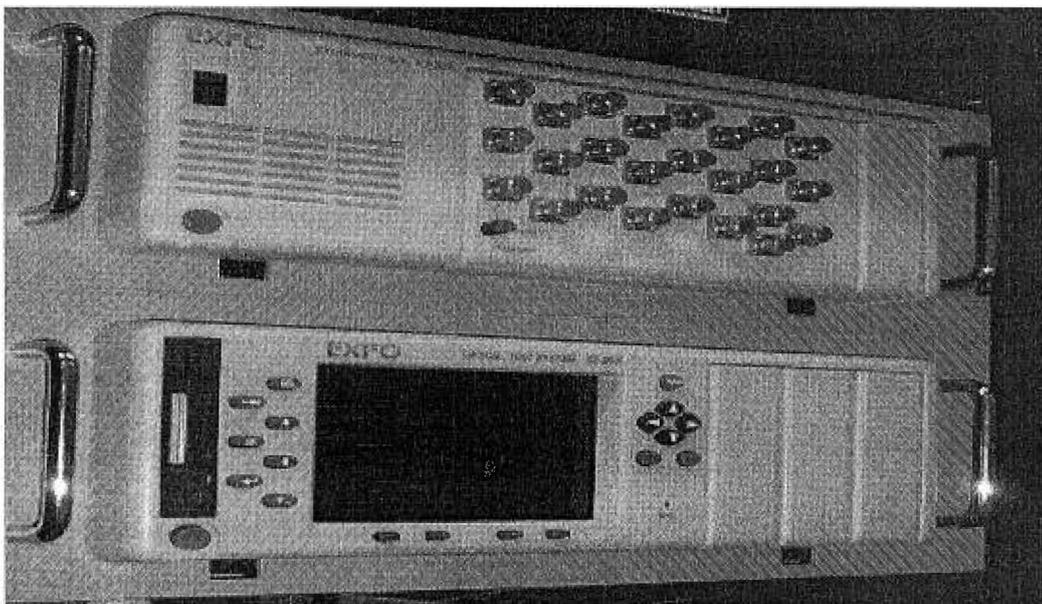
*Fig. 4.4 Foto de una RTU instalada con conmutador óptico externo 1x24*
