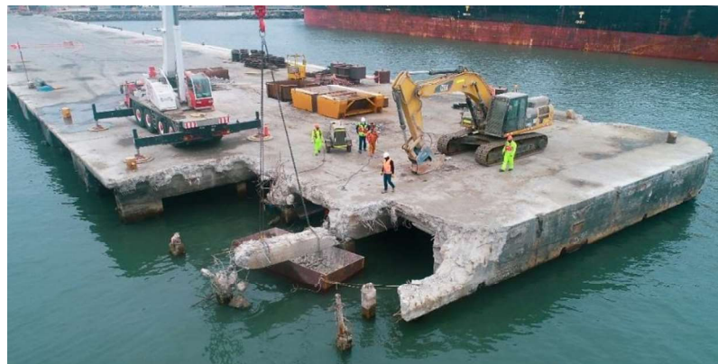
Figura 5.13. Demolición antiguo muelle. Consorcio CRT
