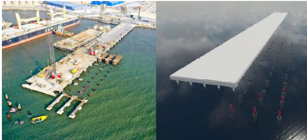
Figura 5.19. Vista general de hincado y colocación de prefabricados. Elaboración propia-CRT
