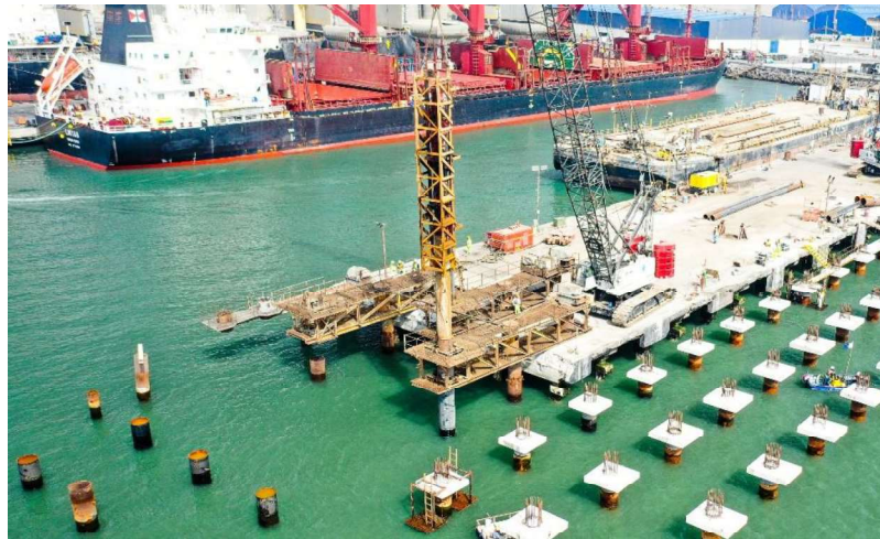
Figura 5.17. Hincado de pilotes Muelle 1. Consorcio CRT
