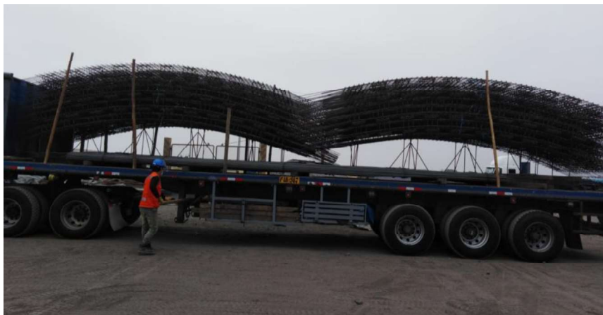
Figura 5.3. Carguío de acero prearmado. TSC – Aceros Arequipa
