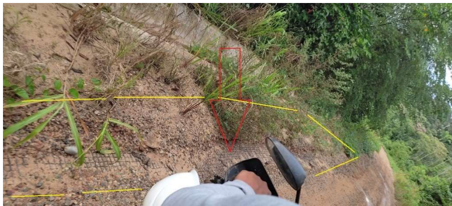
Figura 19. Vista de la afectación de la base granular, geomalla a la intemperie.
