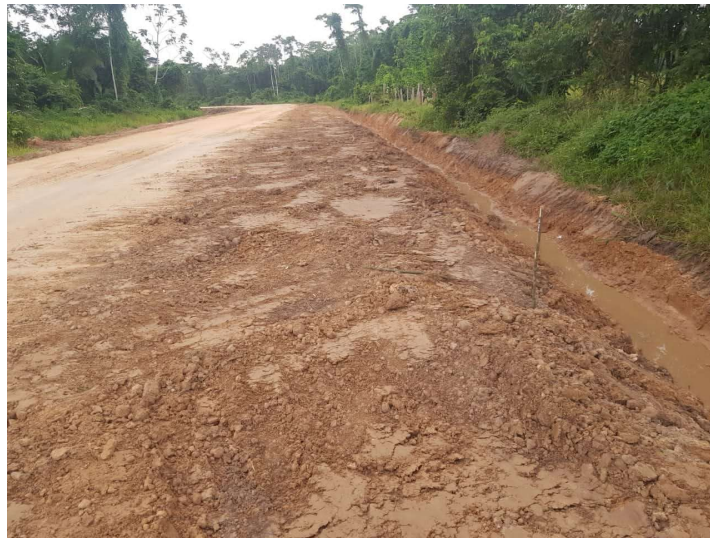
Figura 16. Relleno compactado con material impermeable.
