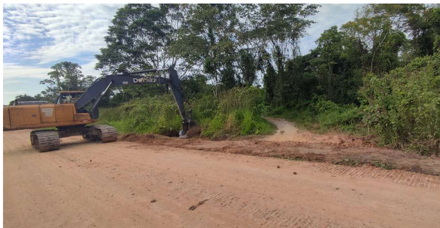
Figura 15. Procedimiento del relleno compactado con material impermeable.
