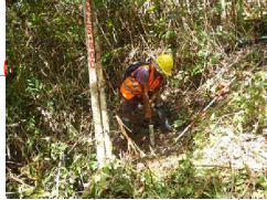
COLOCACION DE BM EN LA PROG.5+000
