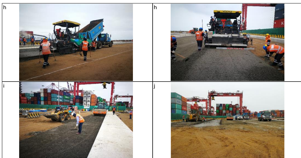
Figura N° 6. 3. Procedimiento constructivo de CBM parte 2
