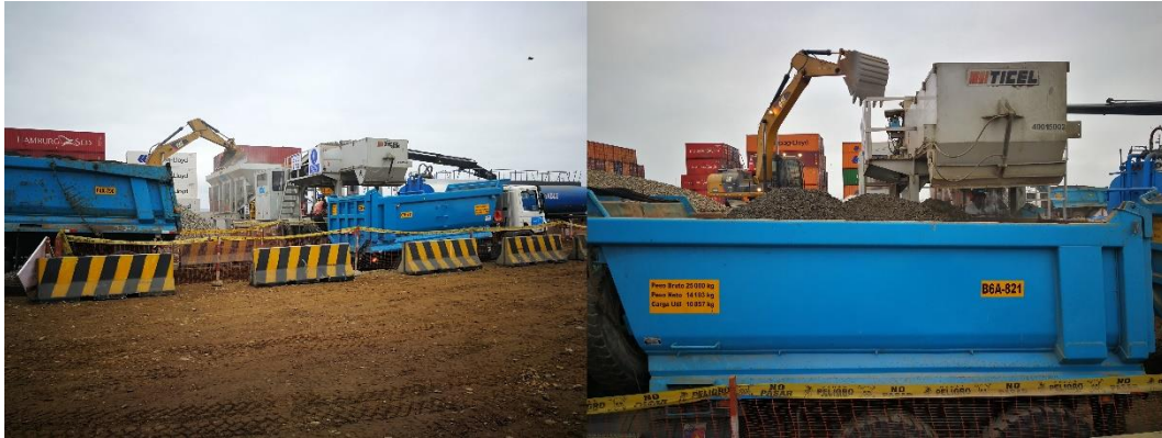
Figura N° 8. 5. Carguío de mezcla sobre volquetes
